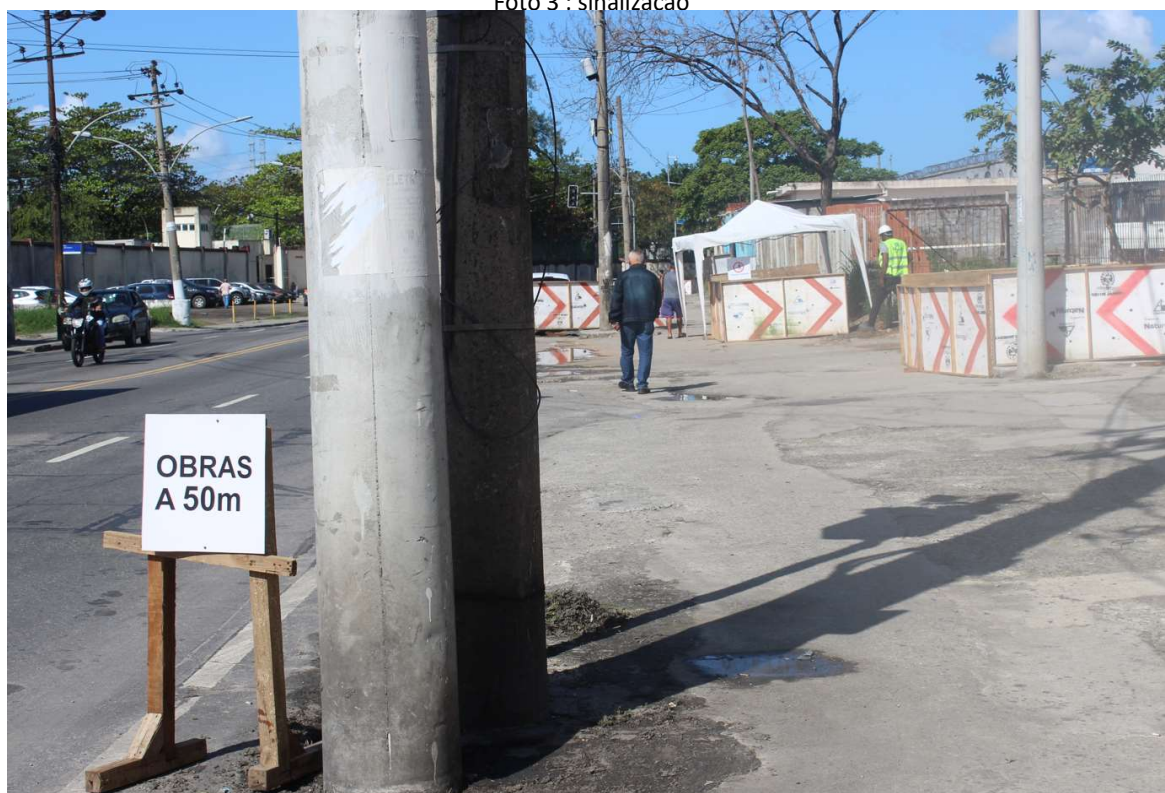
Foto 4 : sinalização de obra à frente
