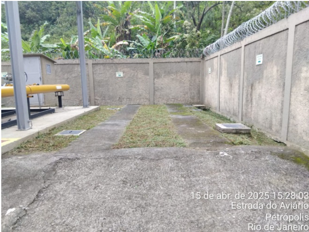
Foto 9: Capina da estação posteriormente conforme.
