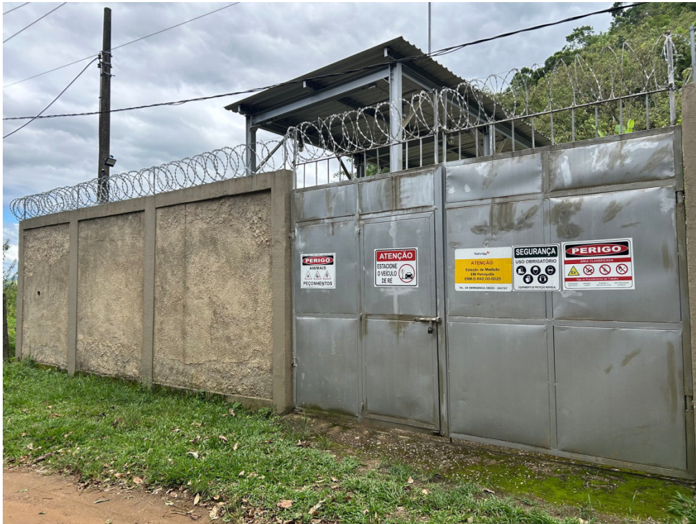
Foto 1: Identificação da estação e sinalizações de segurança no portão de entrada.
