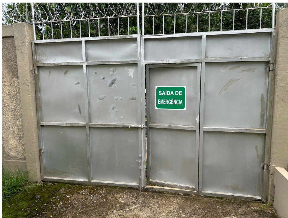
Foto 8: Sinalização de saída de emergência no portão.
