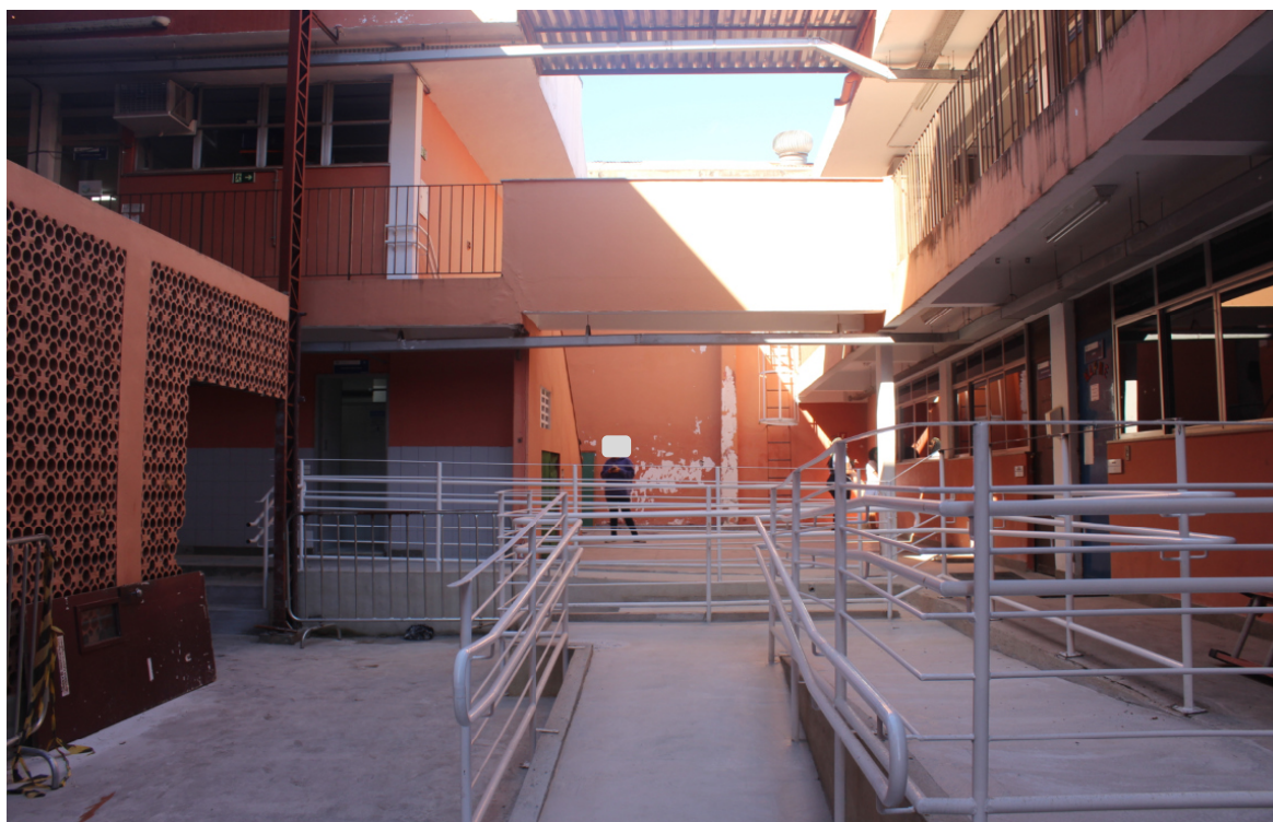
Foto 4: Provável local por onde passará a tubulação
