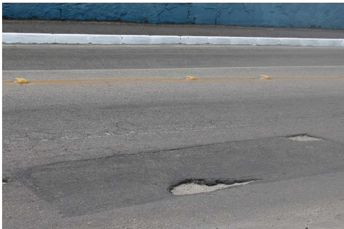
Foto 4 : recomposição com perda de material
