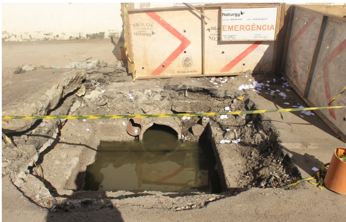
Foto 4: Escavação da Prefeitura a ser drenada
