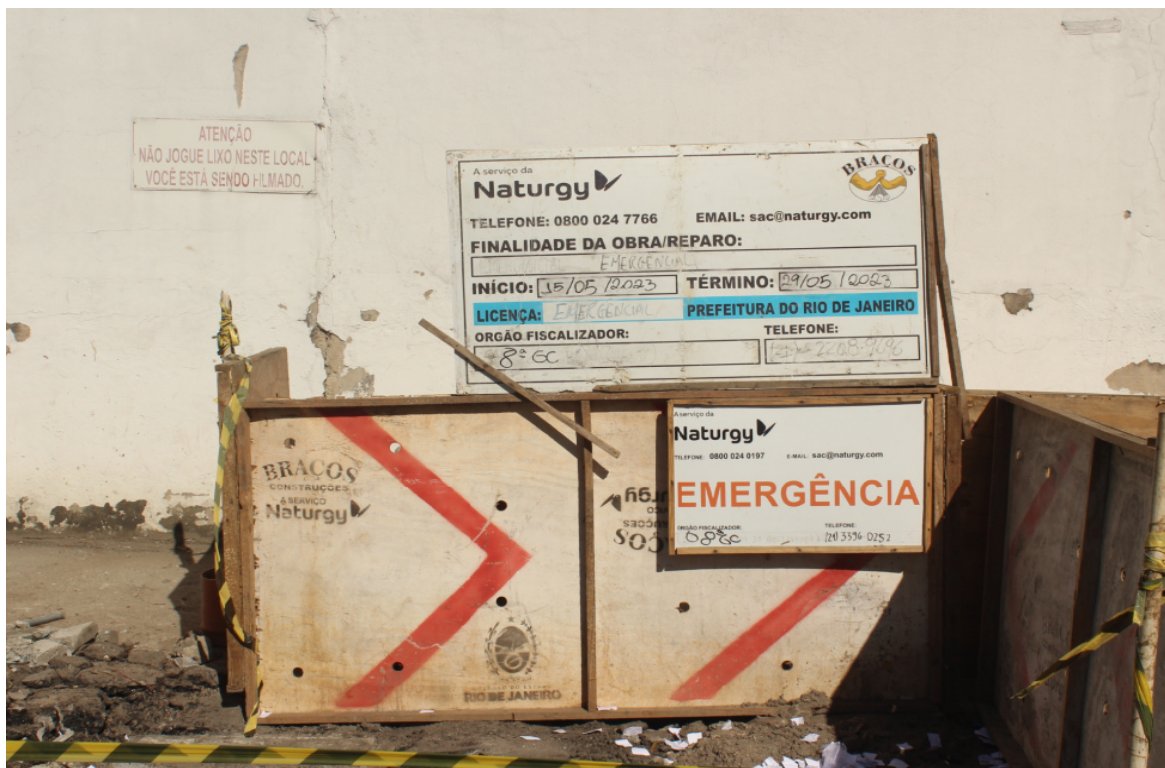
Foto 3: Identificação da obra
