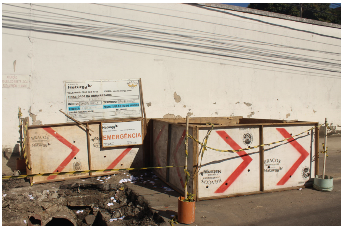
Foto 5: Área isolada pela Concessionária para a execução dos serviços
