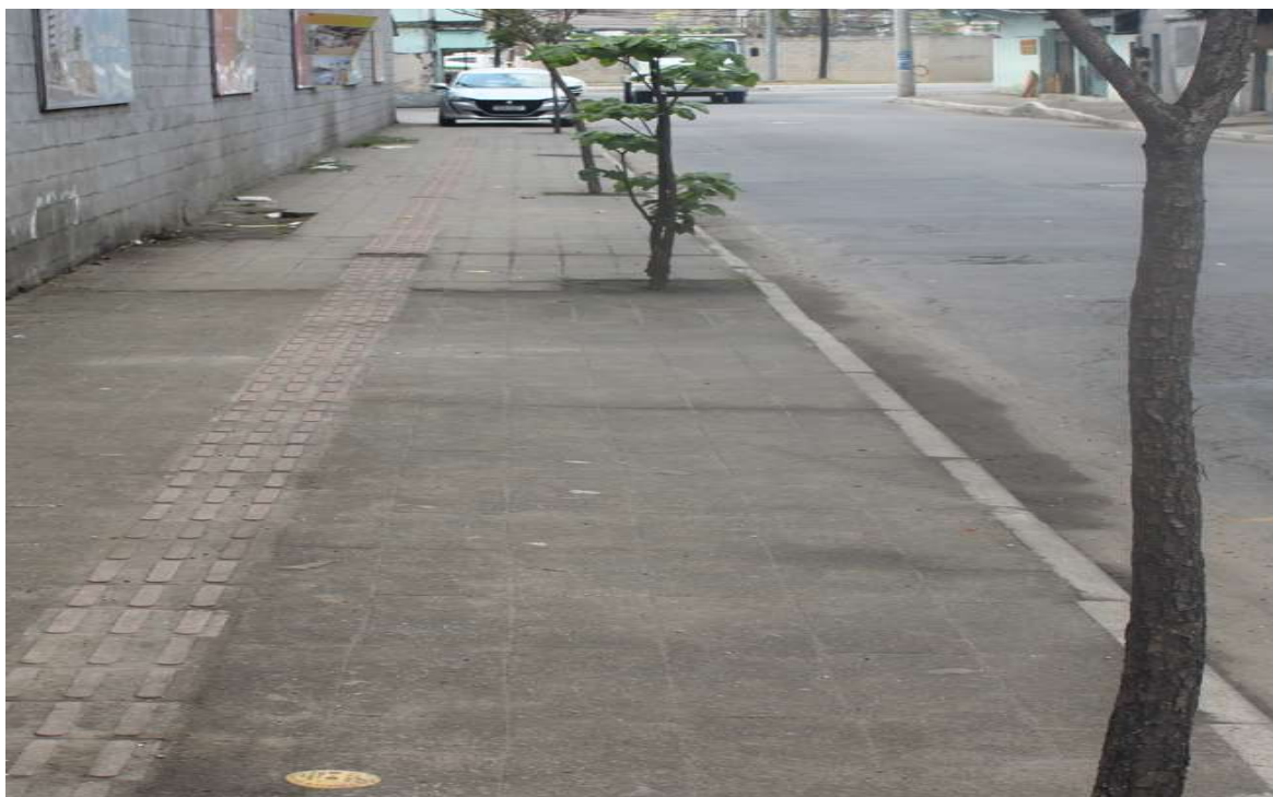
Foto 3 : marco plano indicando presença de rede
