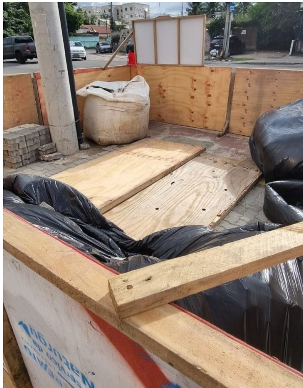
Foto 7: Área de armazenamento de material.
