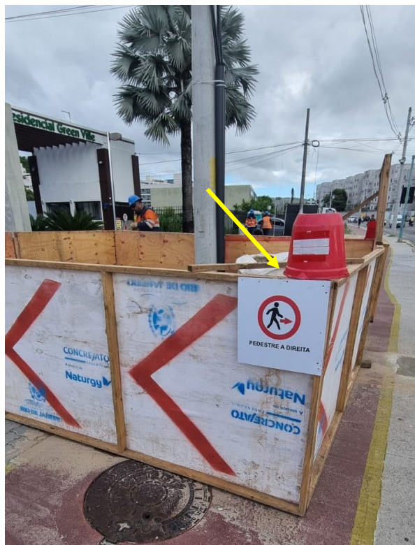
Foto 8: Placas de desvio de pedestre e sinalização noturna.
