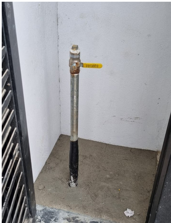
Foto 4: Válvula da rede interna construída. O medidor será instalado posteriormente na ponta da rede.
