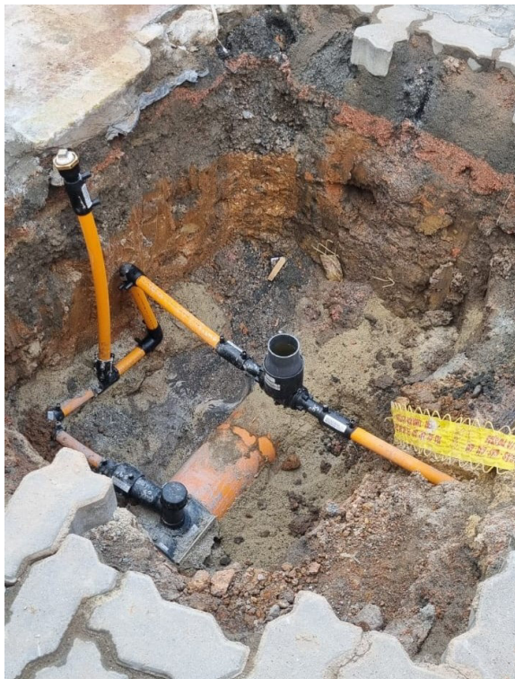
Foto 2: Local de interligação do novo ramal à rede existente na Estrada da Cachamorra.
