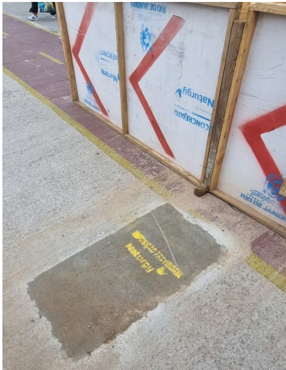
Foto 3: Janela aberta no passeio, recomposta provisoriamente, para a realização da sondagem.
