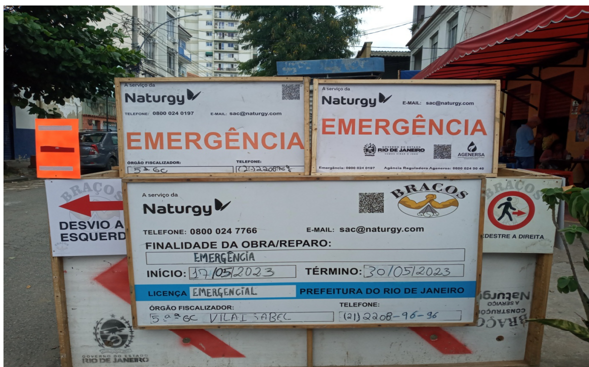
Foto 1: Identificação de obra, sinalização de desvio de trânsito e pedestre
