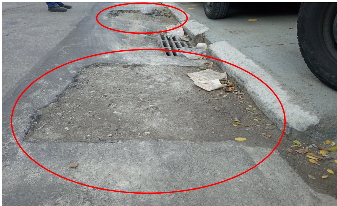
Foto 5: Recomposição insuficiente
