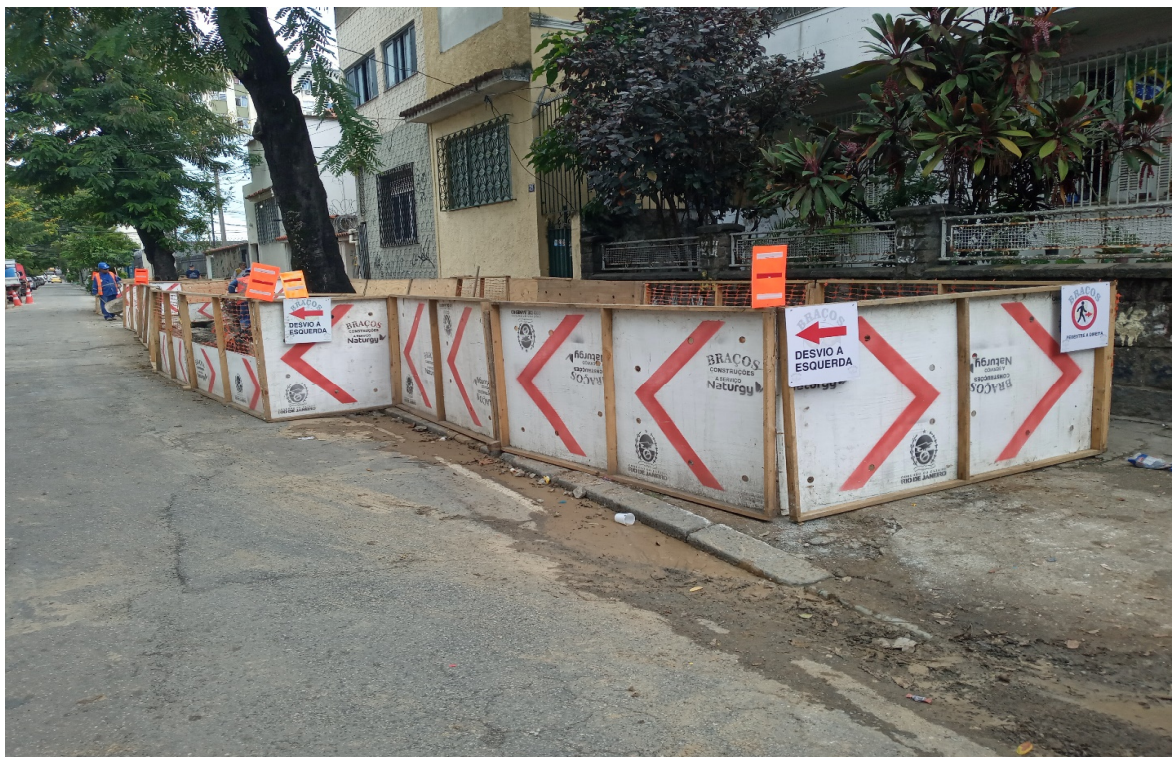
Foto 12: Isolamento e sinalização noturna
