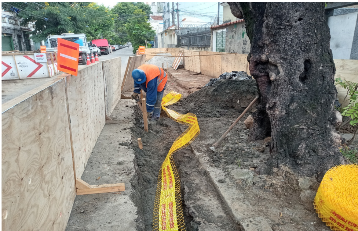
Foto 4: Fechamento de vala e colocação de fita de sinalização
