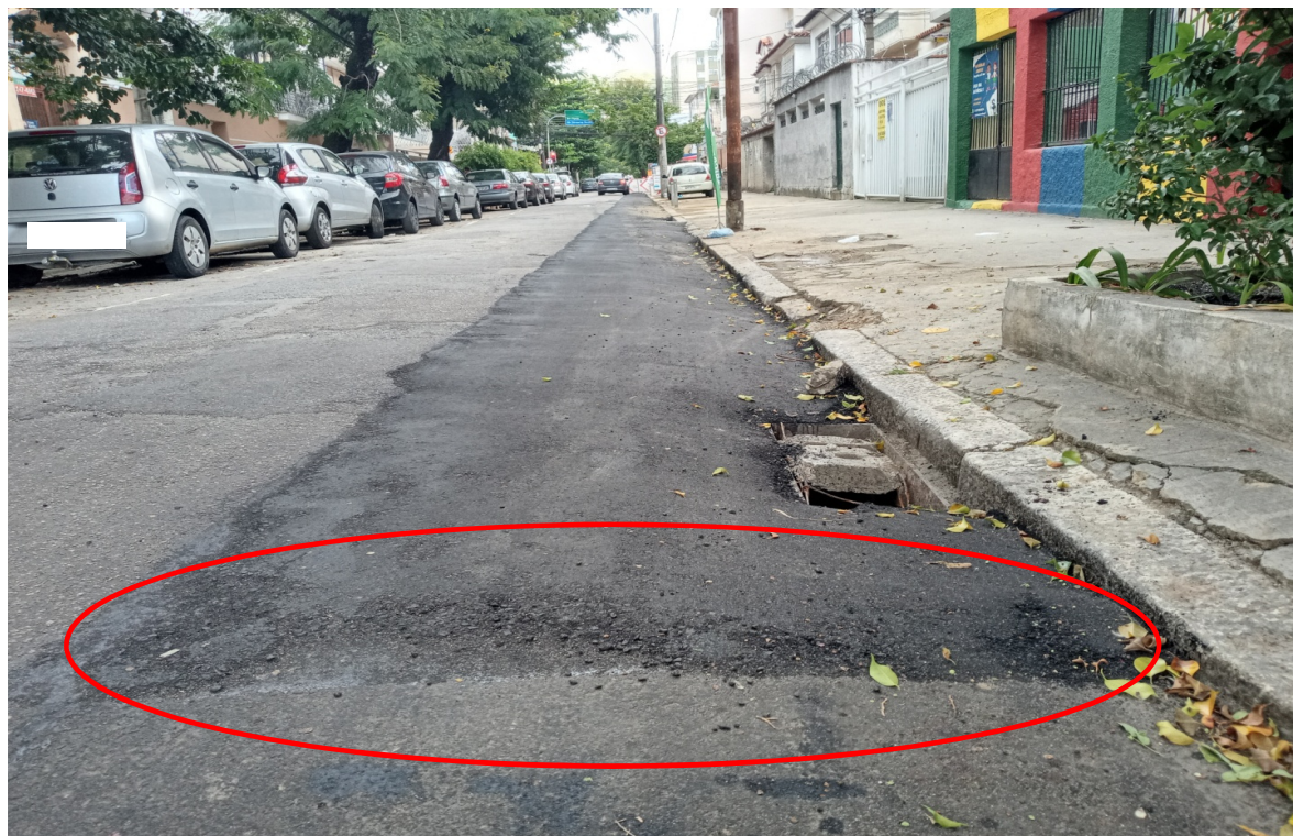
Foto 6: Recomposição com mau acabamento
