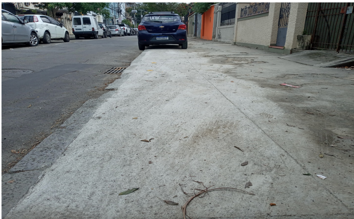
Foto 15: Recomposição da calçada
