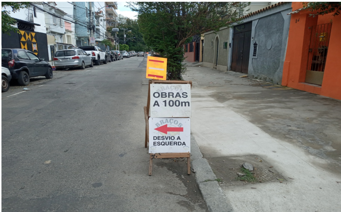
Foto 3: Aviso de obra à frente
