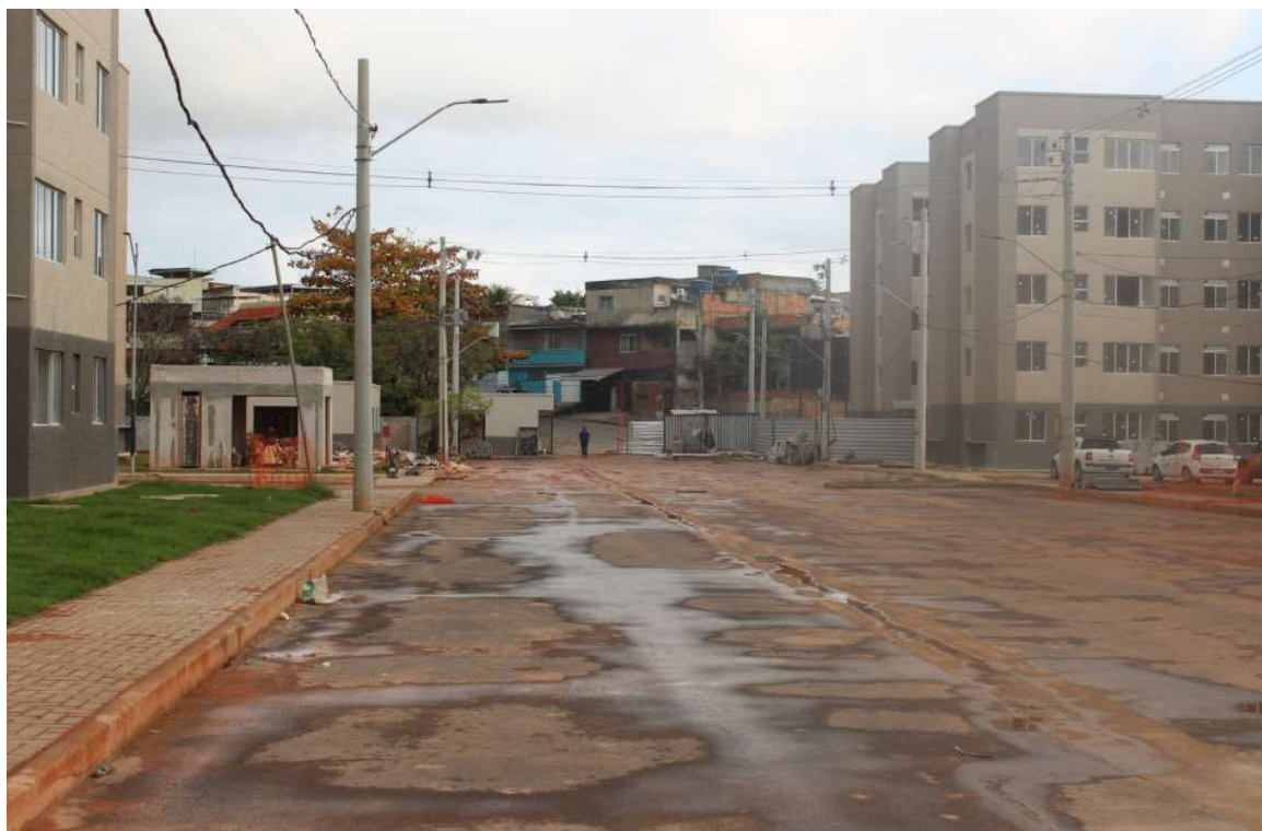
Foto 2 : situação atual da obra
