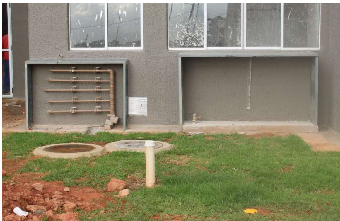
Foto 4 : instalação de PI e marco plano
