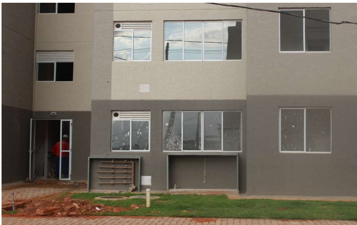
Foto 3 : instalação de PI
