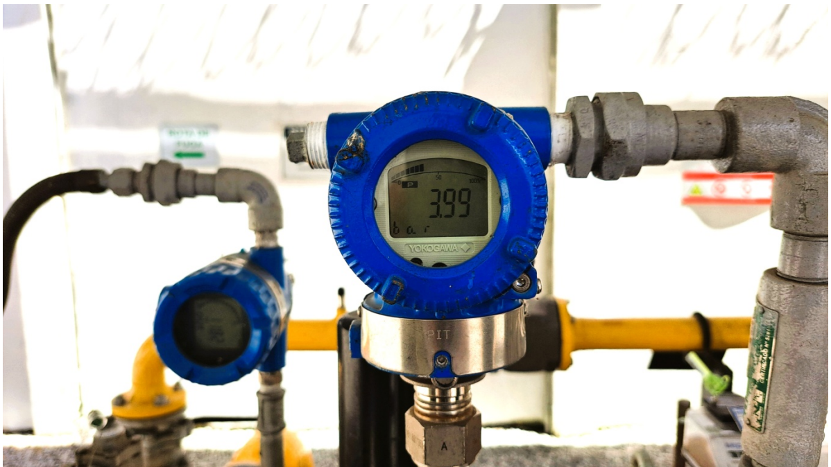
Foto 14: Pressão de Saída da ERM para consumidores – 4 bar
