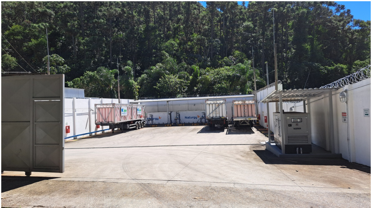
Foto 2: Área de Descompressão
