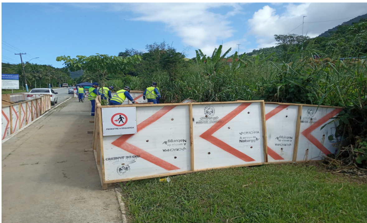
Foto 5: Funcionários executando serviço de limpeza
