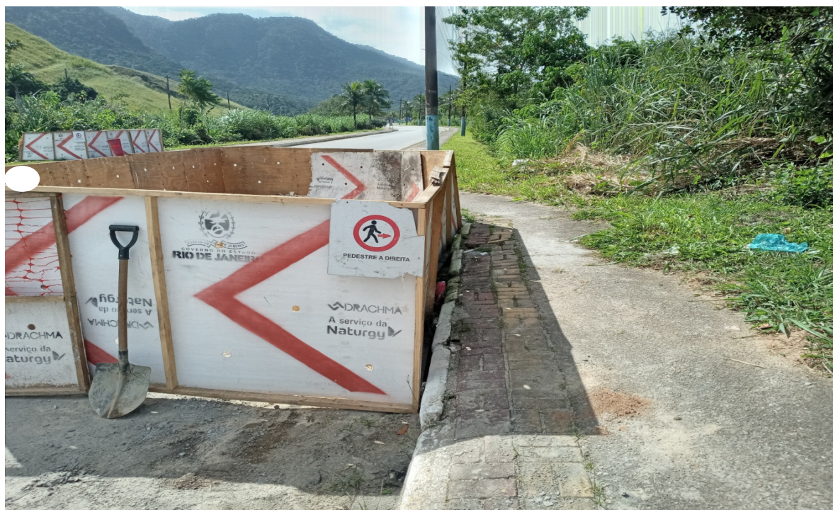
Foto 3: Isolamento e sinalização de pedestre
