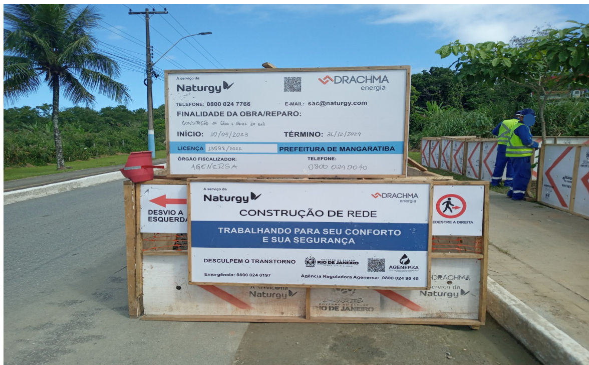
Foto 1: Identificação de obra, sinalização de desvio de trânsito e pedestre
