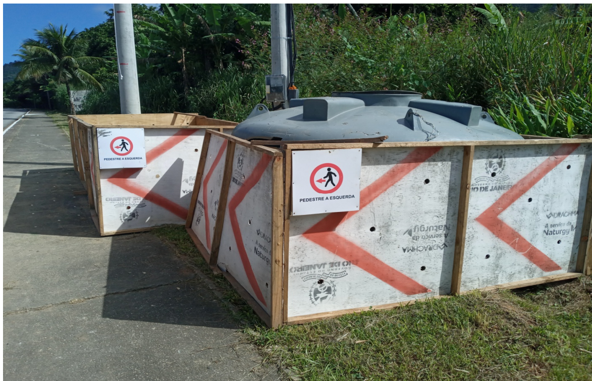
Foto 10: Armazenamento de líquido usado na perfuração (Biodegradável)
