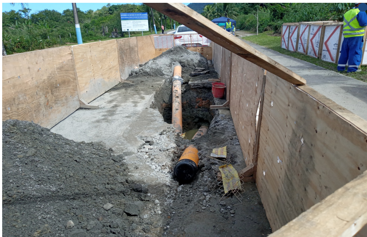
Foto 4: Rede a ser conectada (PE DN 200 mm)
