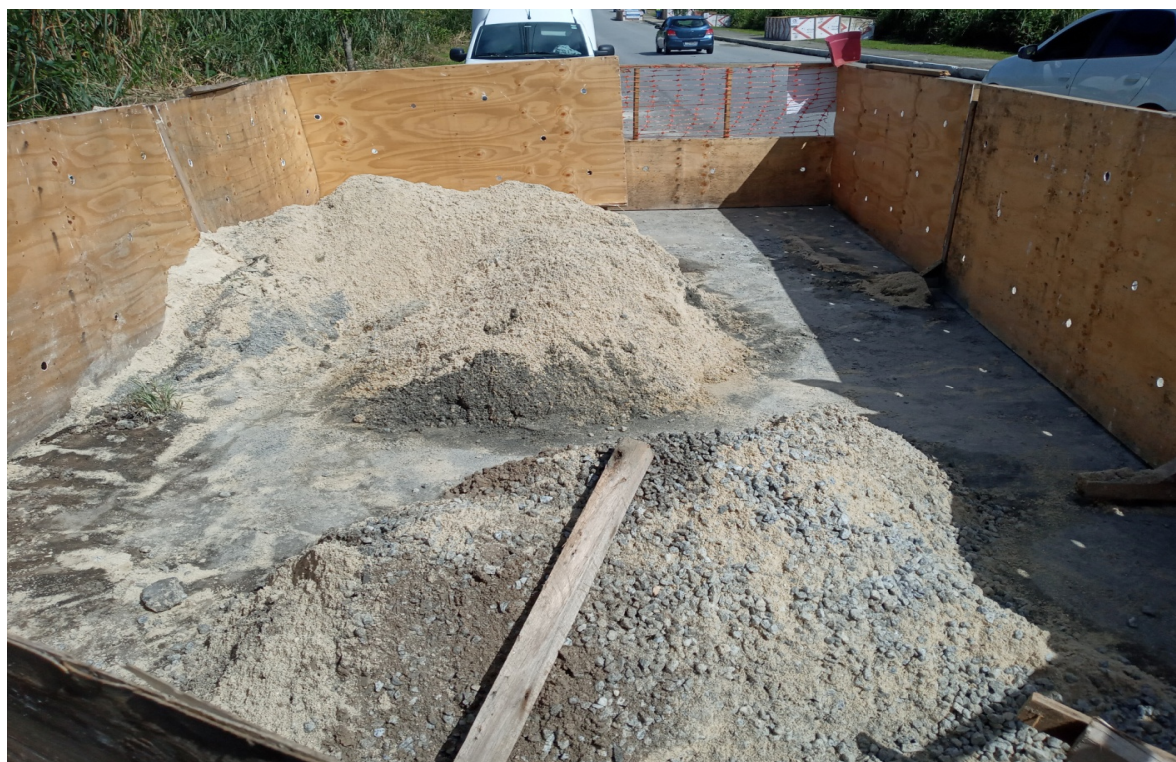
Foto 12: Armazenamento de material
