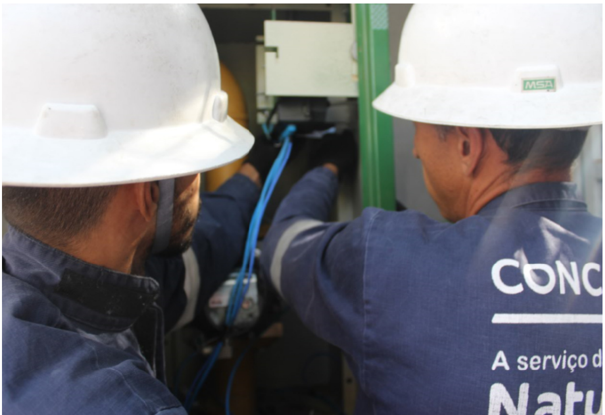
Figura 12 - Desmontagem da caixa e a separação do medidor e do conversor
