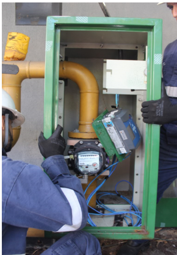
Figura 13 - Desmontagem da caixa e a separação do medidor e do conversor
