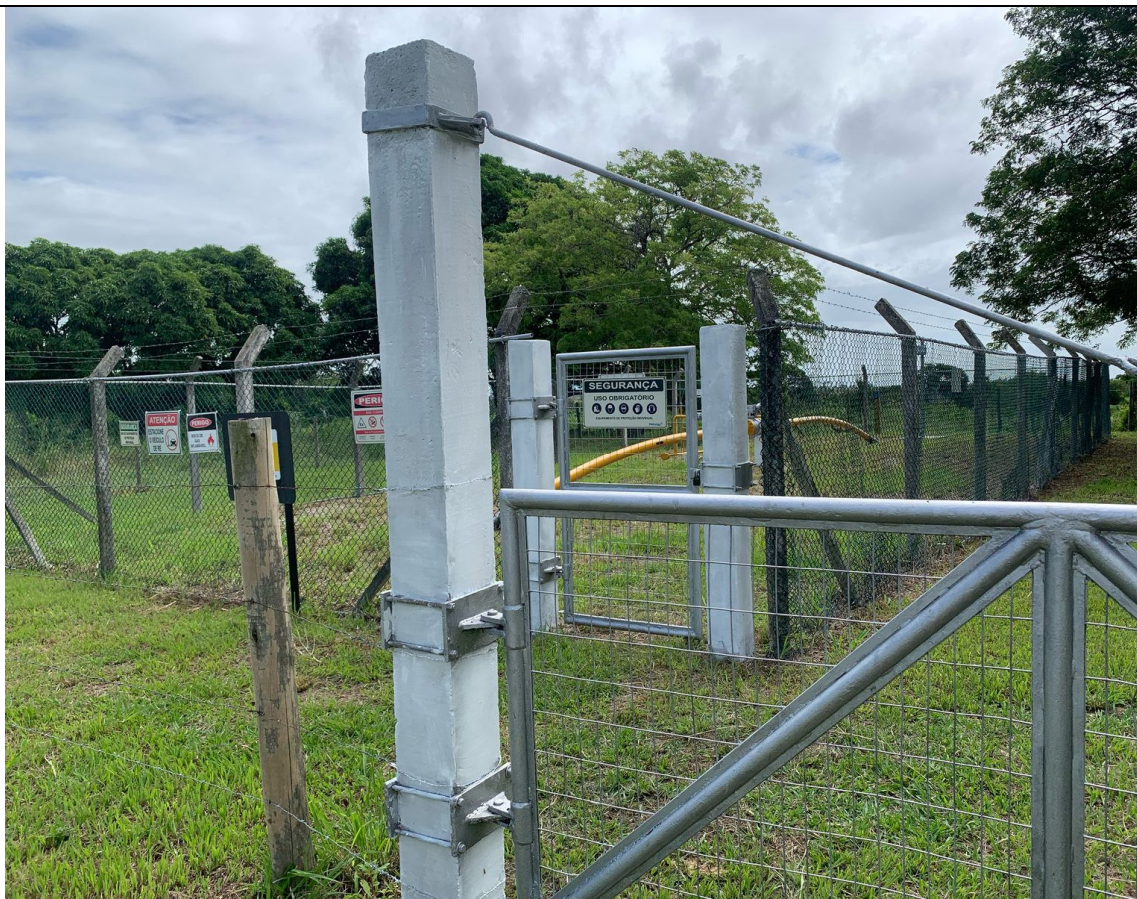
Foto 7: Cerca da estação.
