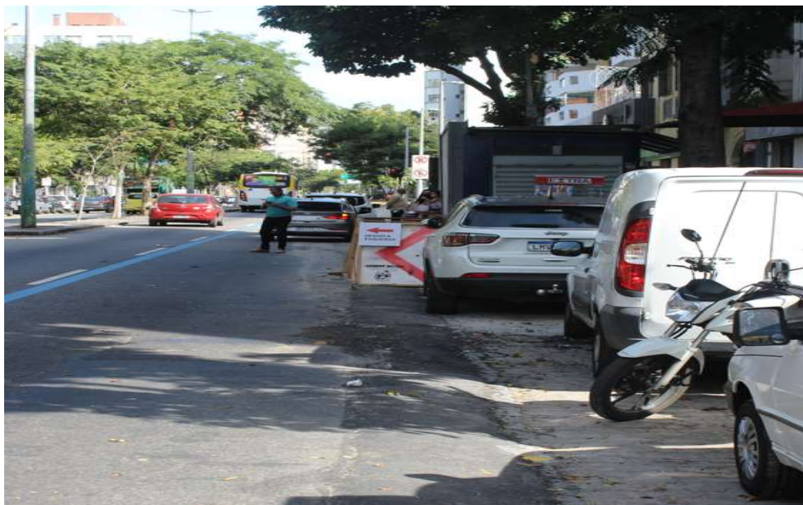
Foto 3 : recomposição e sinalização
