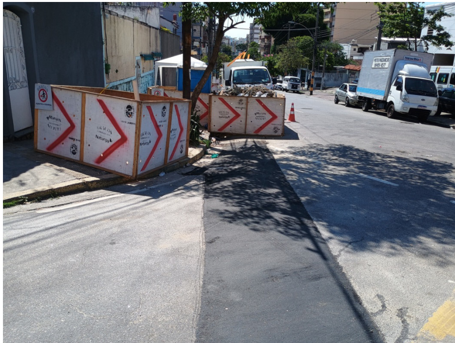
Foto 5: recomposição provisória após assentamento da tubulação no lado par.
