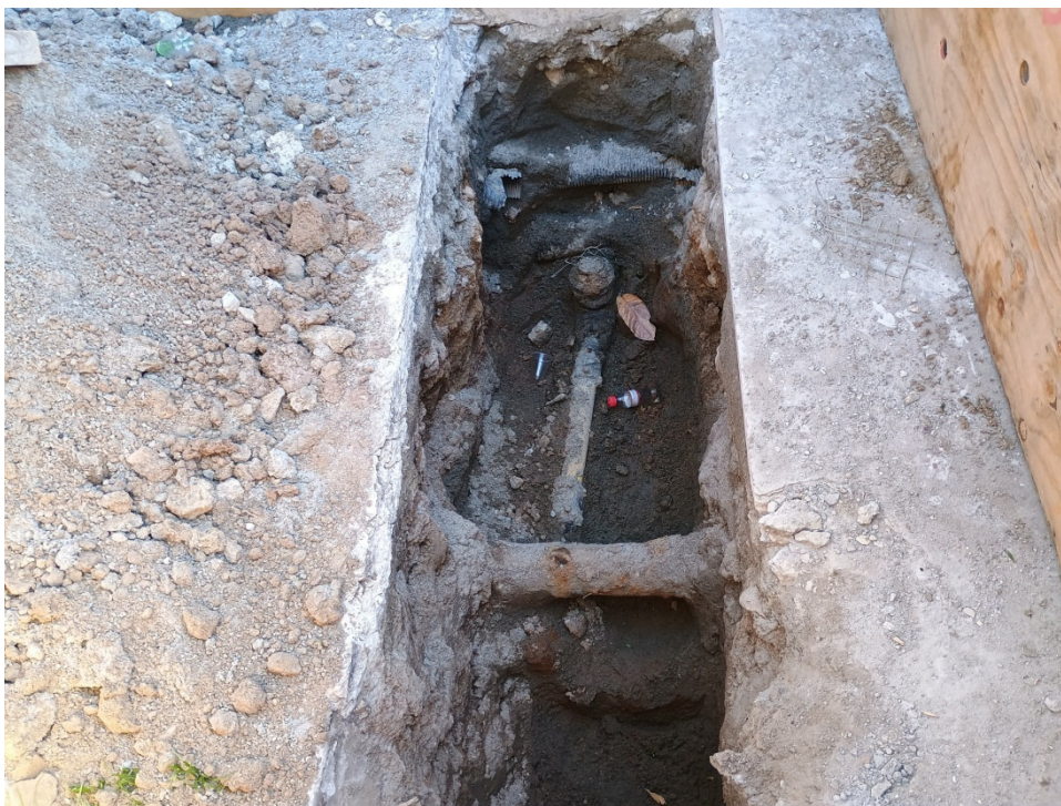
Foto 6: trecho aberto para migração de ramal antigo para a nova linha.
