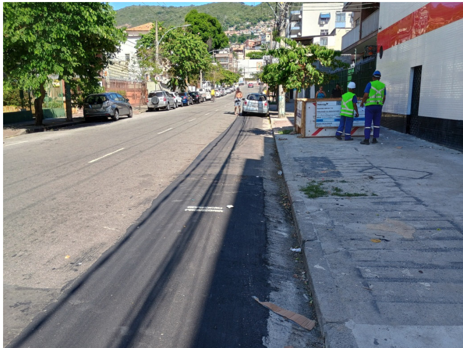
Foto 4: recomposição provisória após assentamento da tubulação no lado par.
