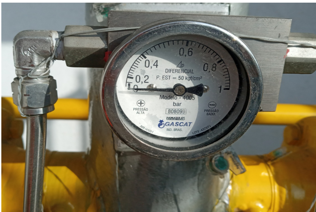
FOTO 6: Manômetro do filtro e conexões (com lacre).
