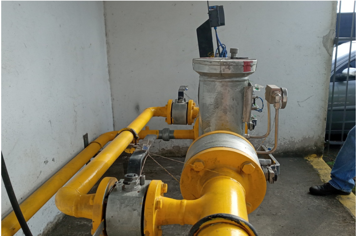
FOTO 11: Vista lateral do barrilhete do medidor de gás (com lacre).
