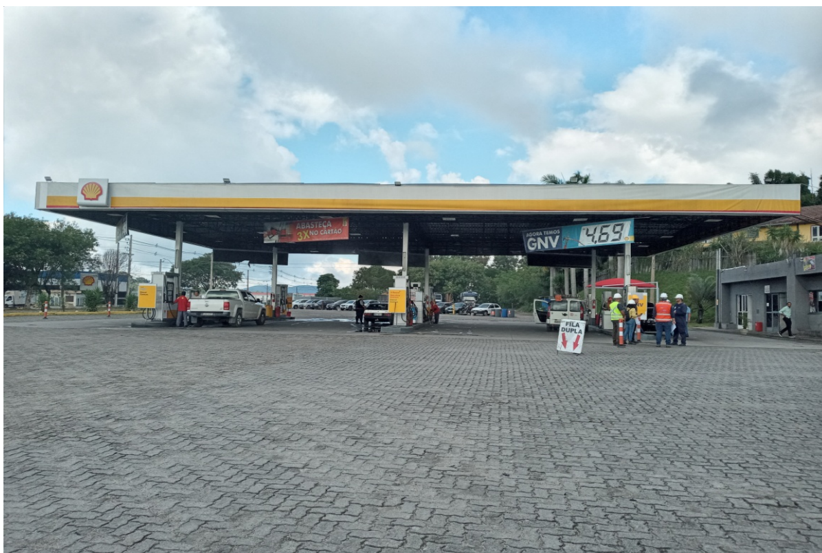
FOTO 1: Vista do Posto a ser vistoriado
