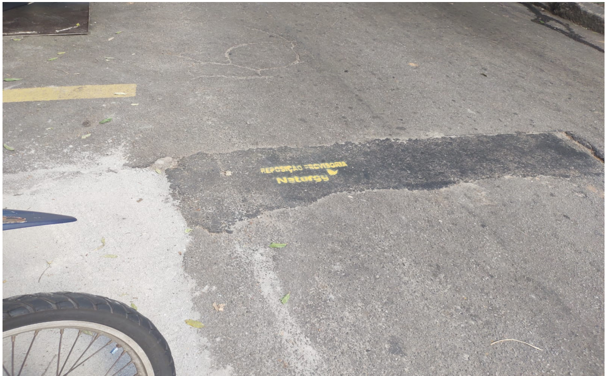
Foto 2: Recomposição provisória travessia de via em frente ao número 129.
