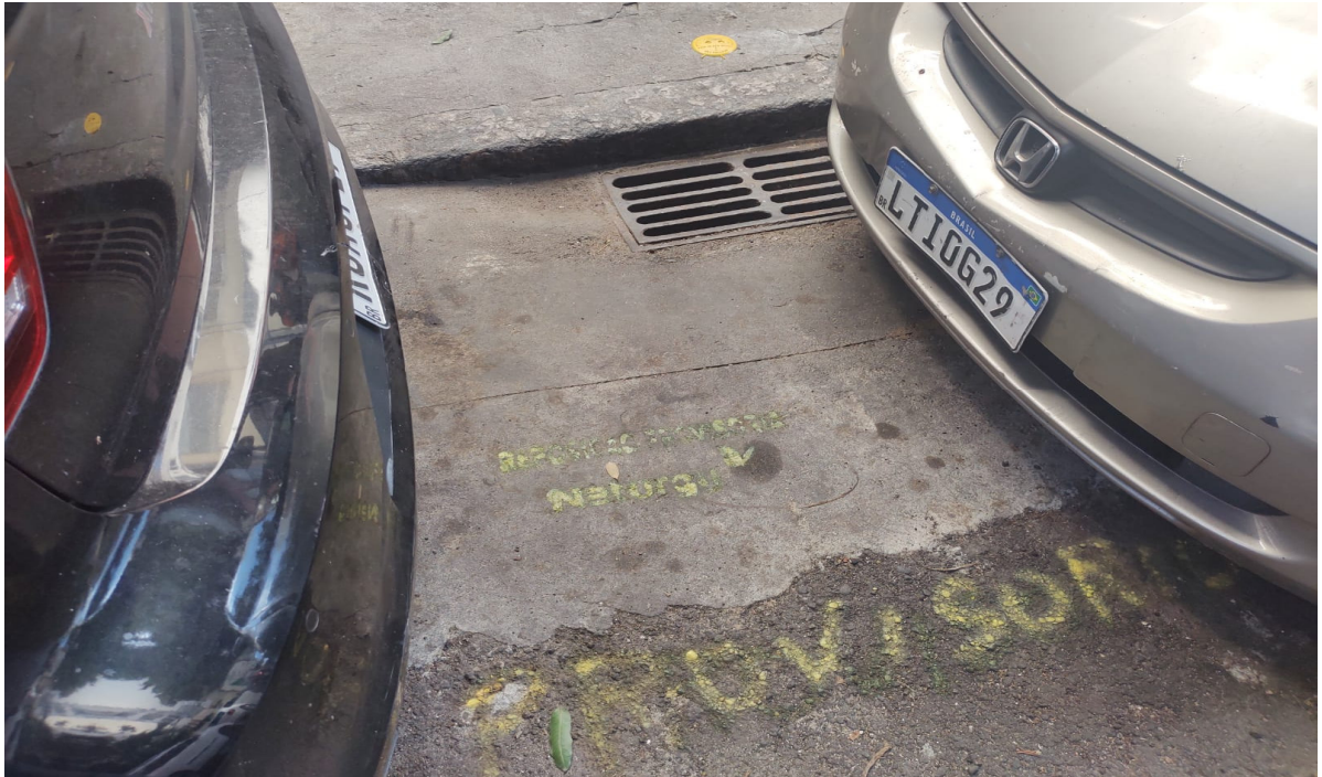
Foto 3: Recomposição provisória e marco plano em frente ao número 101.
