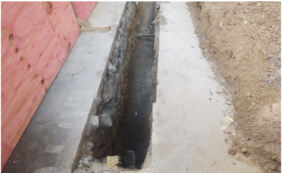
Foto 8: Valas para assentamento de tubulação em frente ao número 47.
