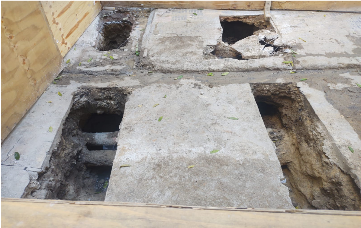
Foto 5: Valas para instalação de ramais em frente aos números 53 e 47.
