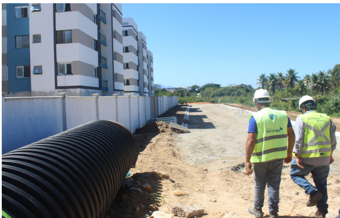
Foto 4: Futura passagem de carros
