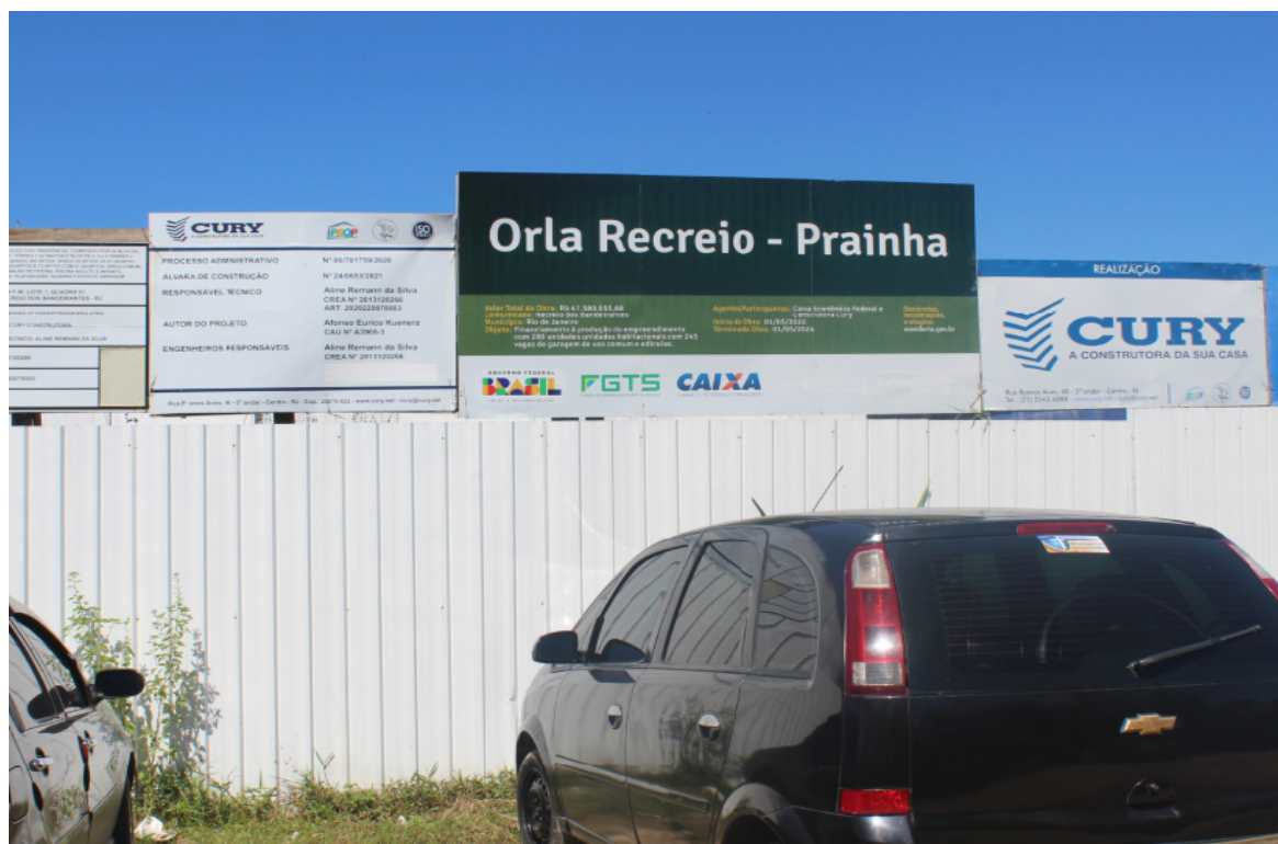
Foto 1: Fachada do condomínio
