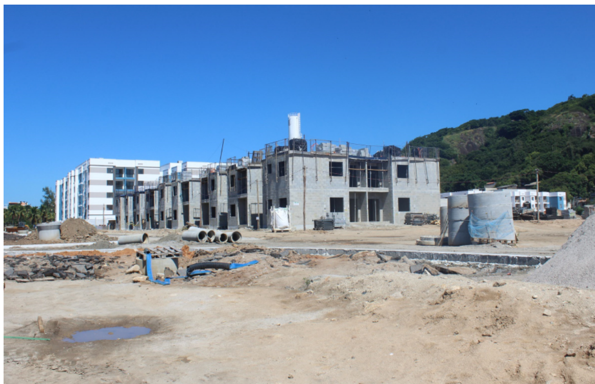
Foto 2: Situação atual das obras
