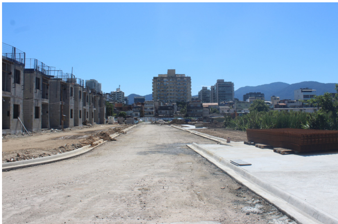
Foto 3: Futura passagem de carros
