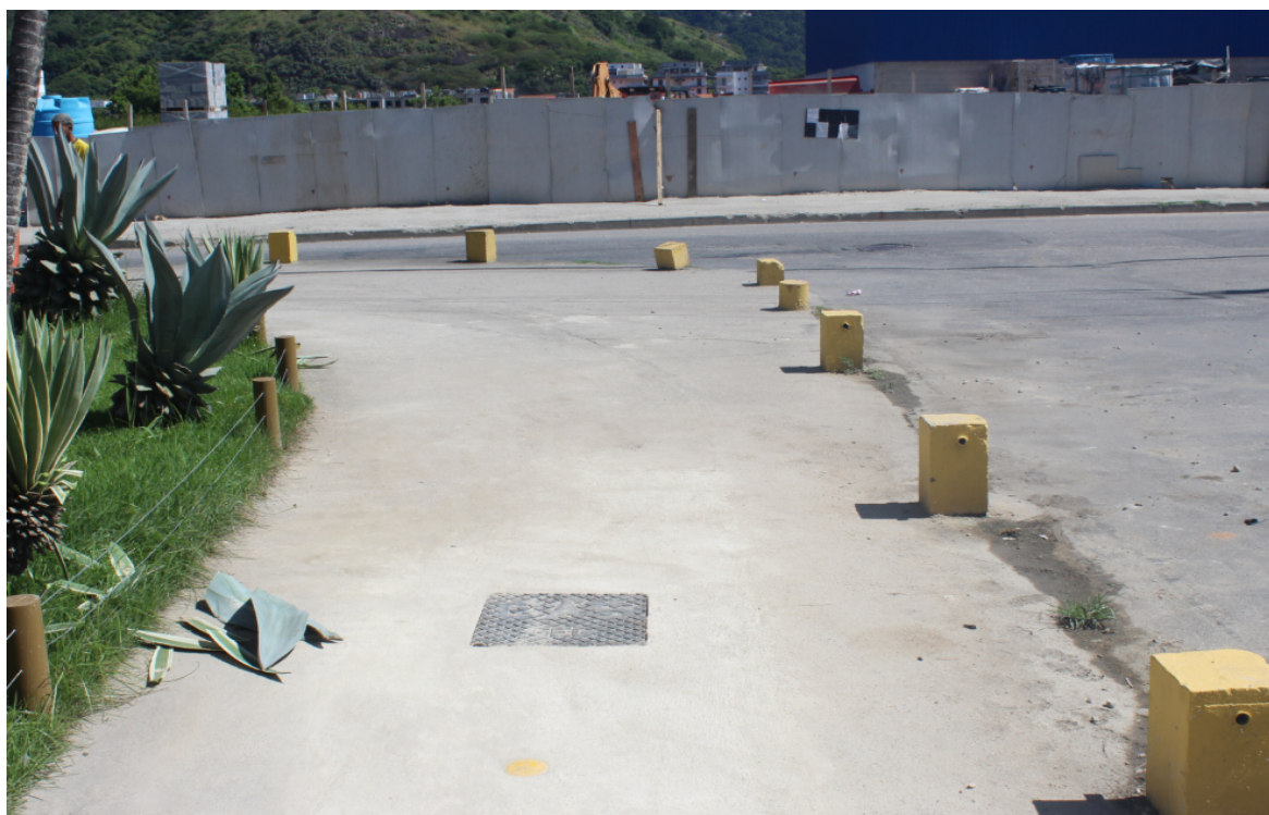
Foto 6: Ponto de interligação da rede
