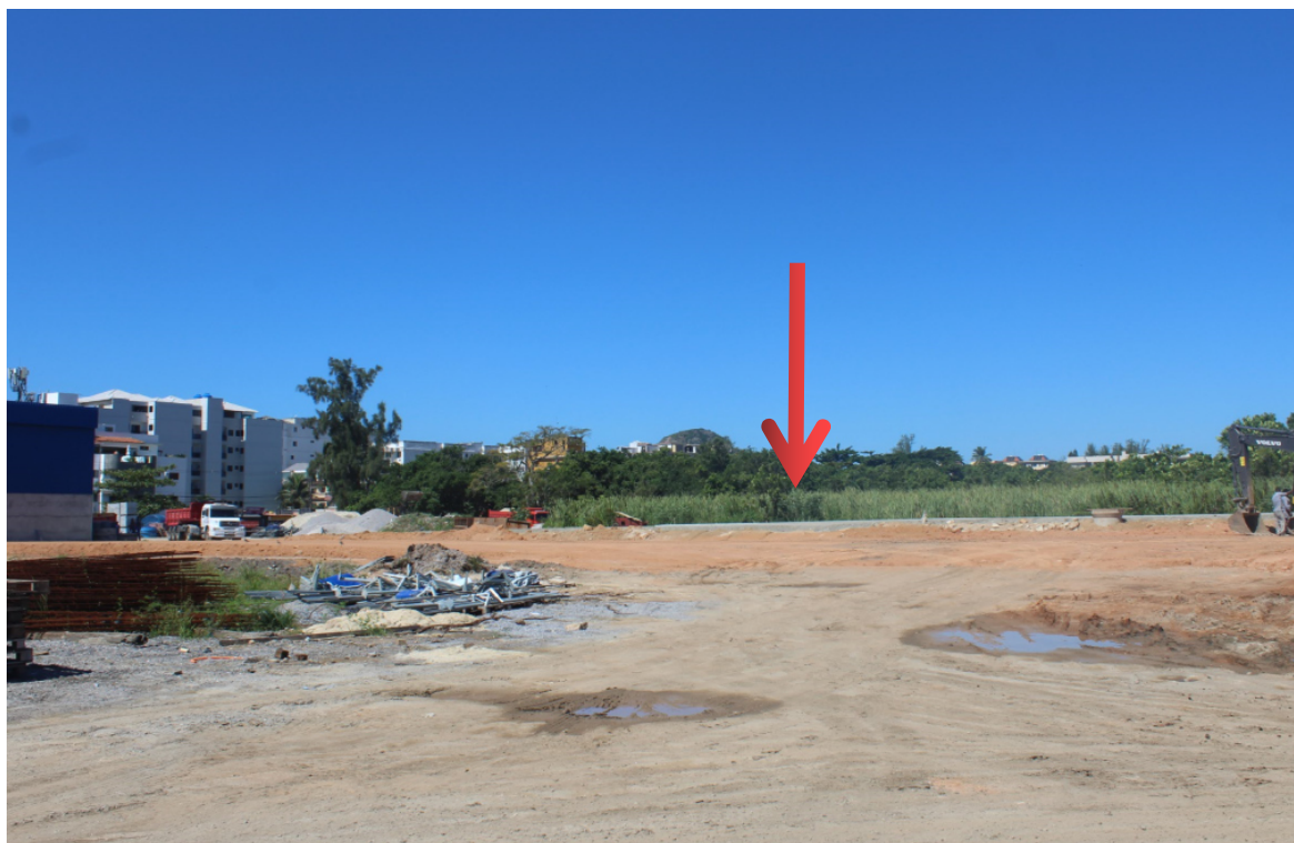
Foto 5: Futura passagem de carros
