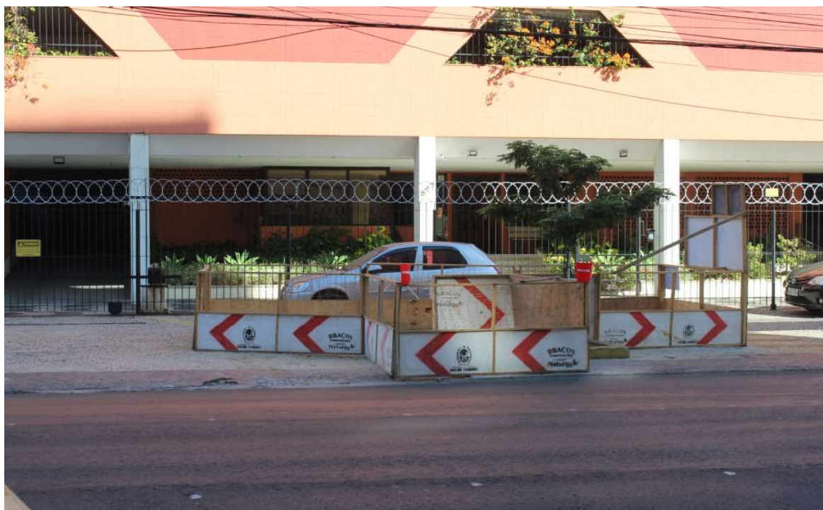
Foto 3 : sinalização de obra
