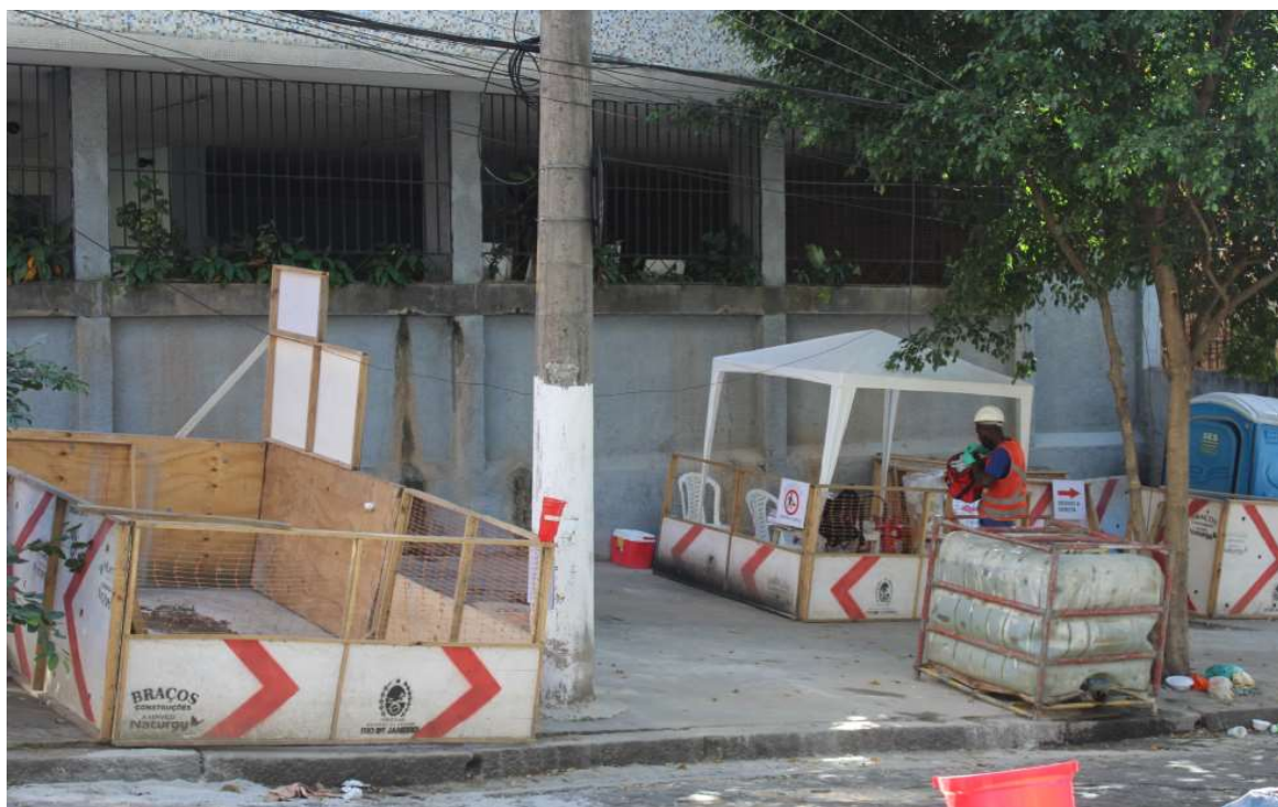
Foto 2 : local de vivência e armazenamento de material
