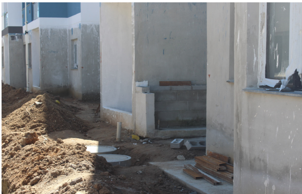
Foto 6: Futuras instalações de PIs
