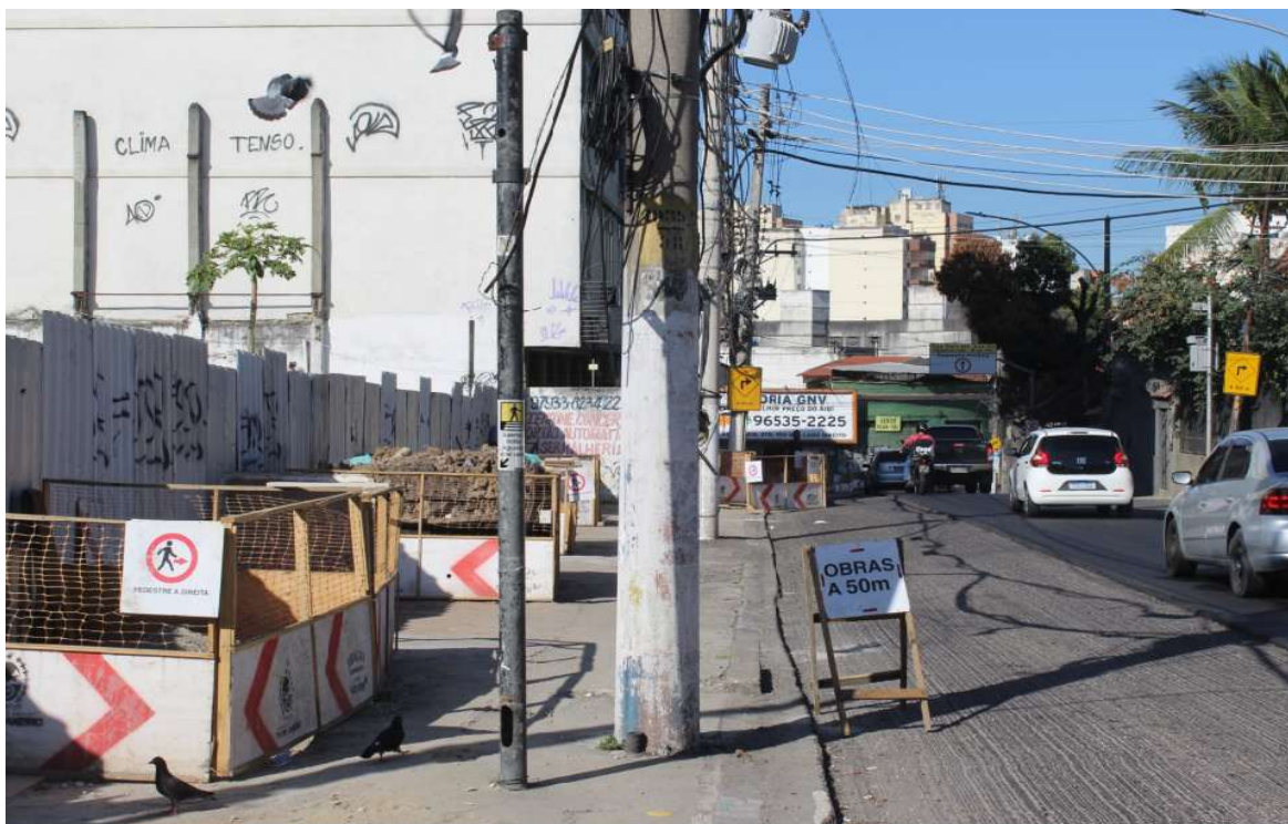
Foto 2 : sinalização de obra
