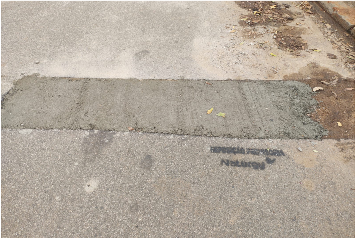
Foto 7: Travessia de via com recomposição provisória.
