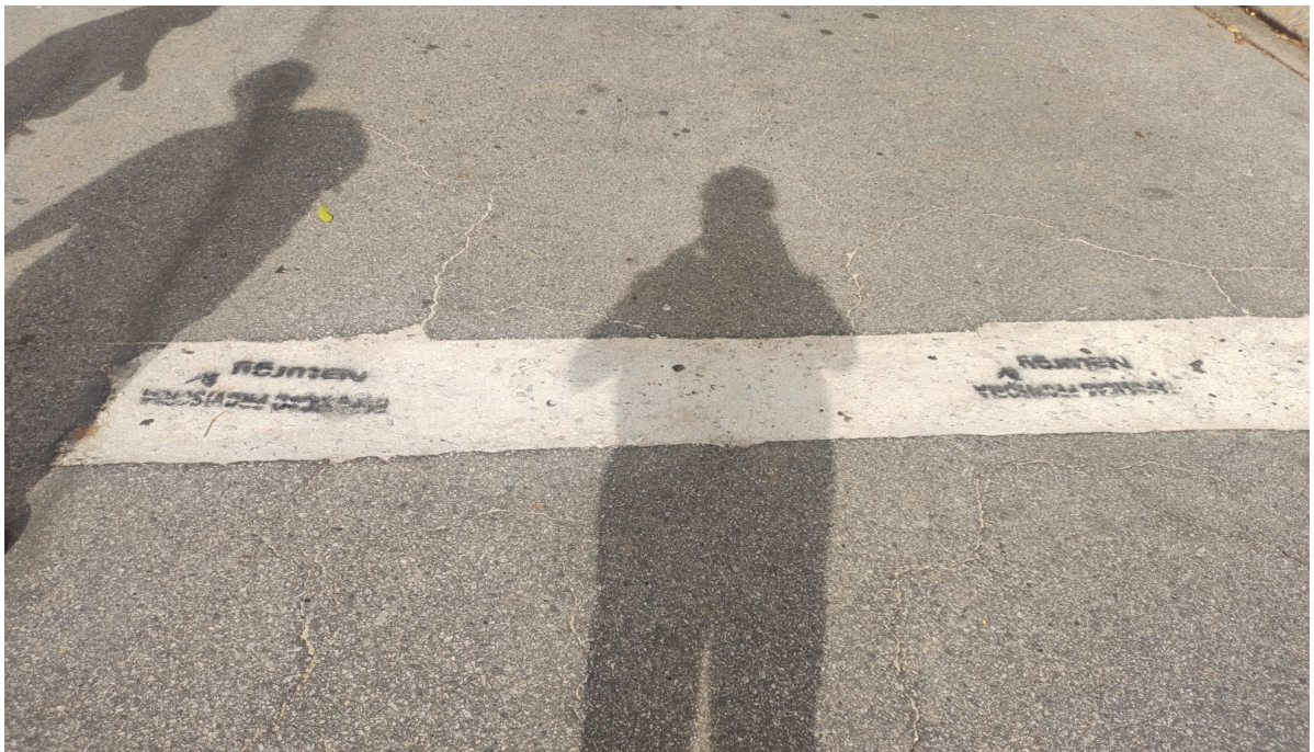
Foto 8: Travessia de via com recomposição provisória.
