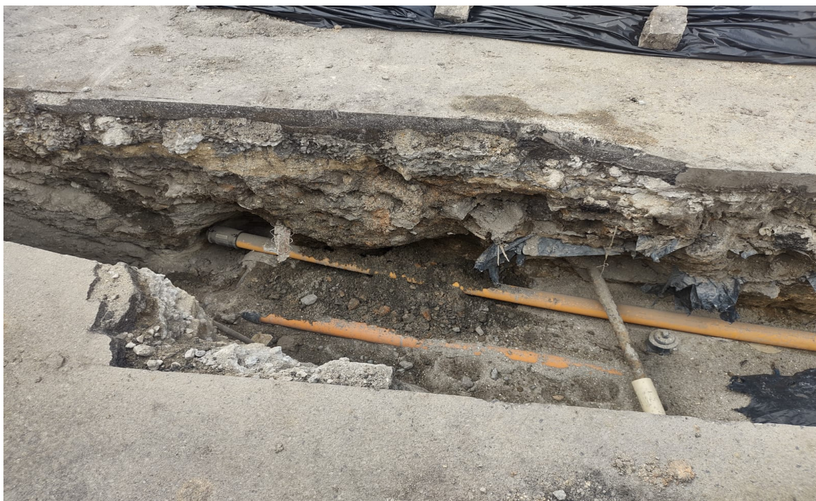
Foto 6: Ligação com a rede na esquina da Rua Silvio Rosa com Rua Ferreira Cardoso.
