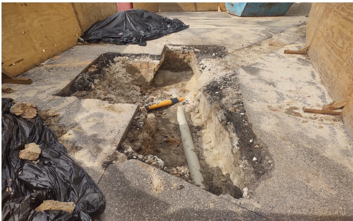
Foto 5: Ligação com a rede na esquina da Rua Pires de Carvalho com Rua Ferreira Cardoso.
