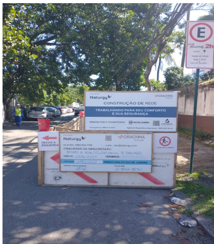
Foto 1: Identificação da obra, sinalização e isolamento
