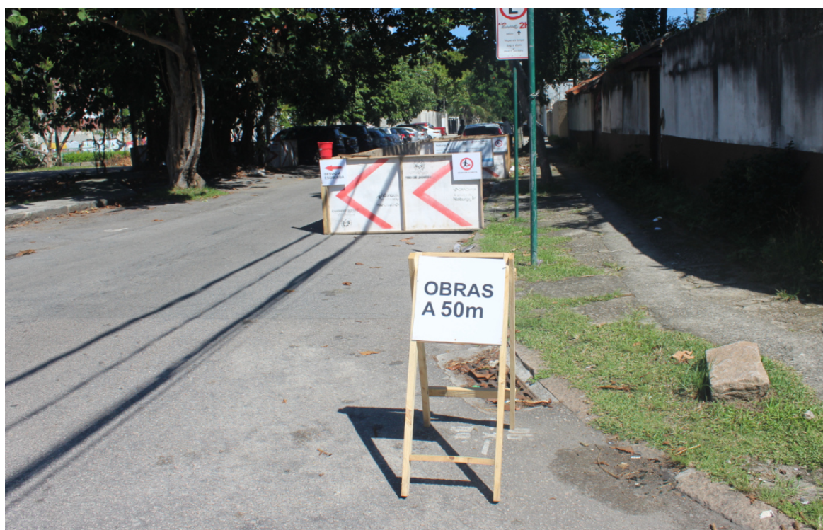
Foto 2: Indicação de obras à frente
