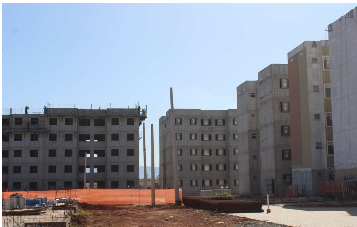
Foto 2 : situação atual das obras do condomínio
