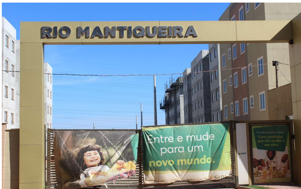
Foto 1 : fachada do condomínio
