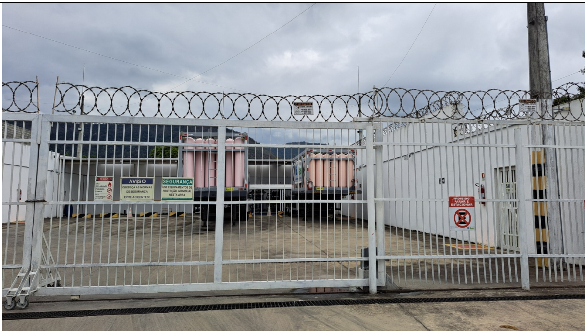
Foto 1: Sinalização da entrada da estação
