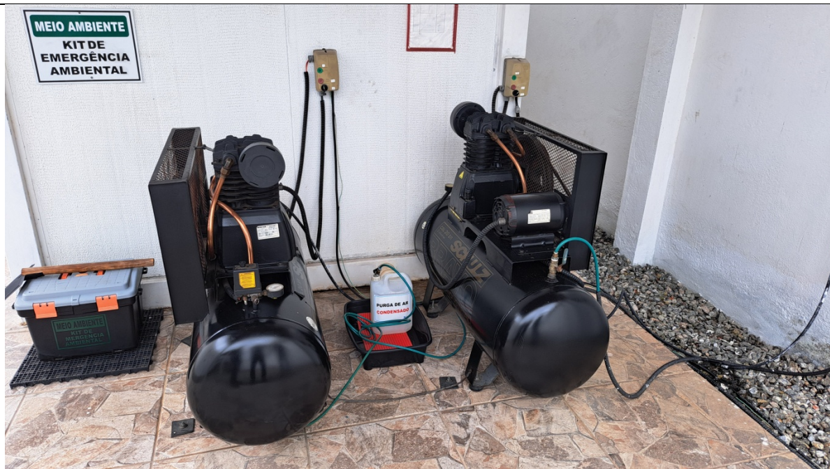
Foto 11: Compressores para suprimento de ar para acionamento pneumática da instrumentação no modulo ERM.
