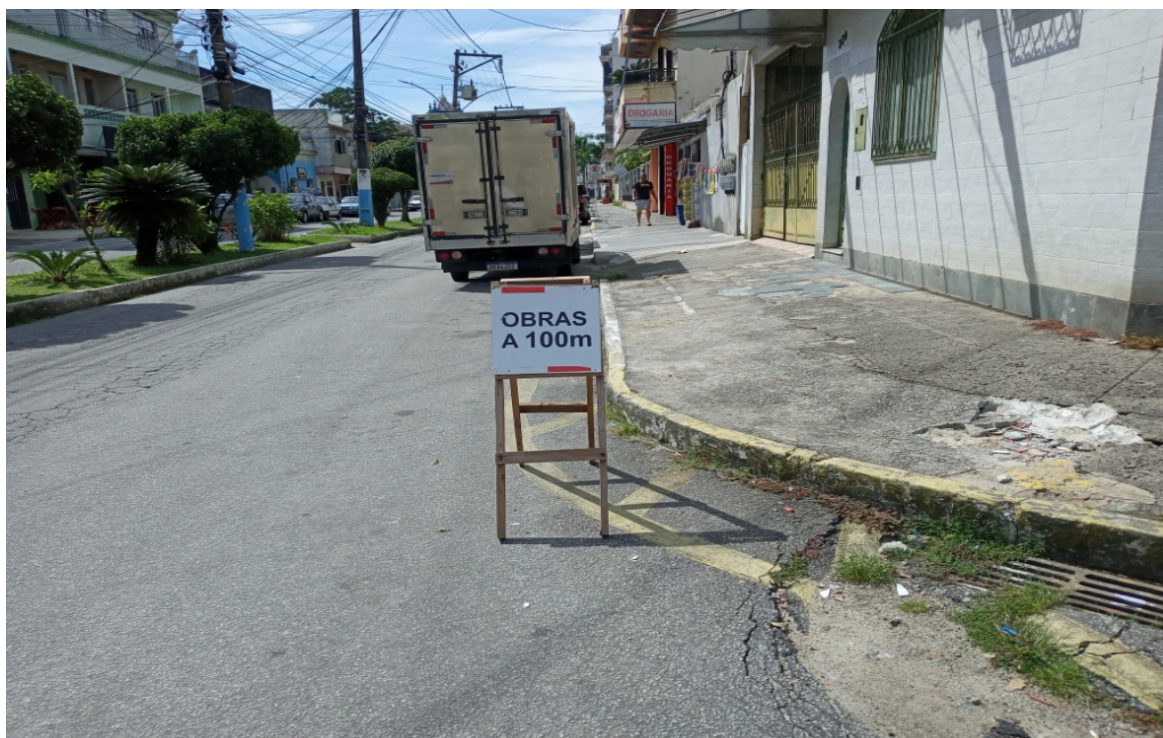
Foto 3: Aviso de obra
