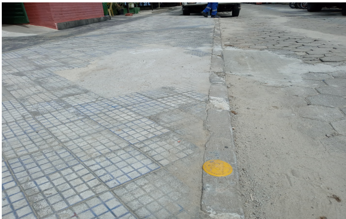
Foto 11: Recomposição provisória e marco plano
