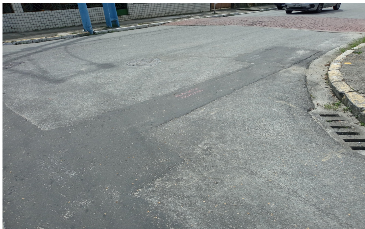
Foto 6: Recomposição provisória de travessia
