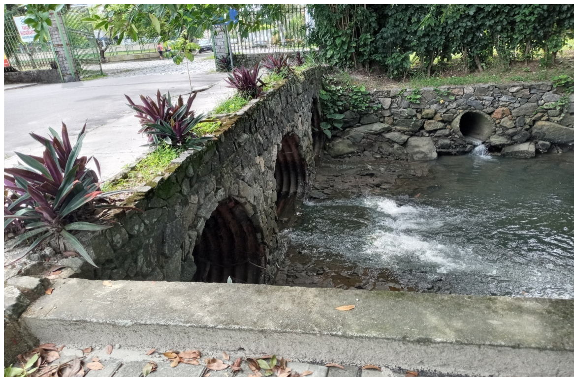
Foto 12: Ponto onde será realizada travessia em tubo de aço para interligação de rede
