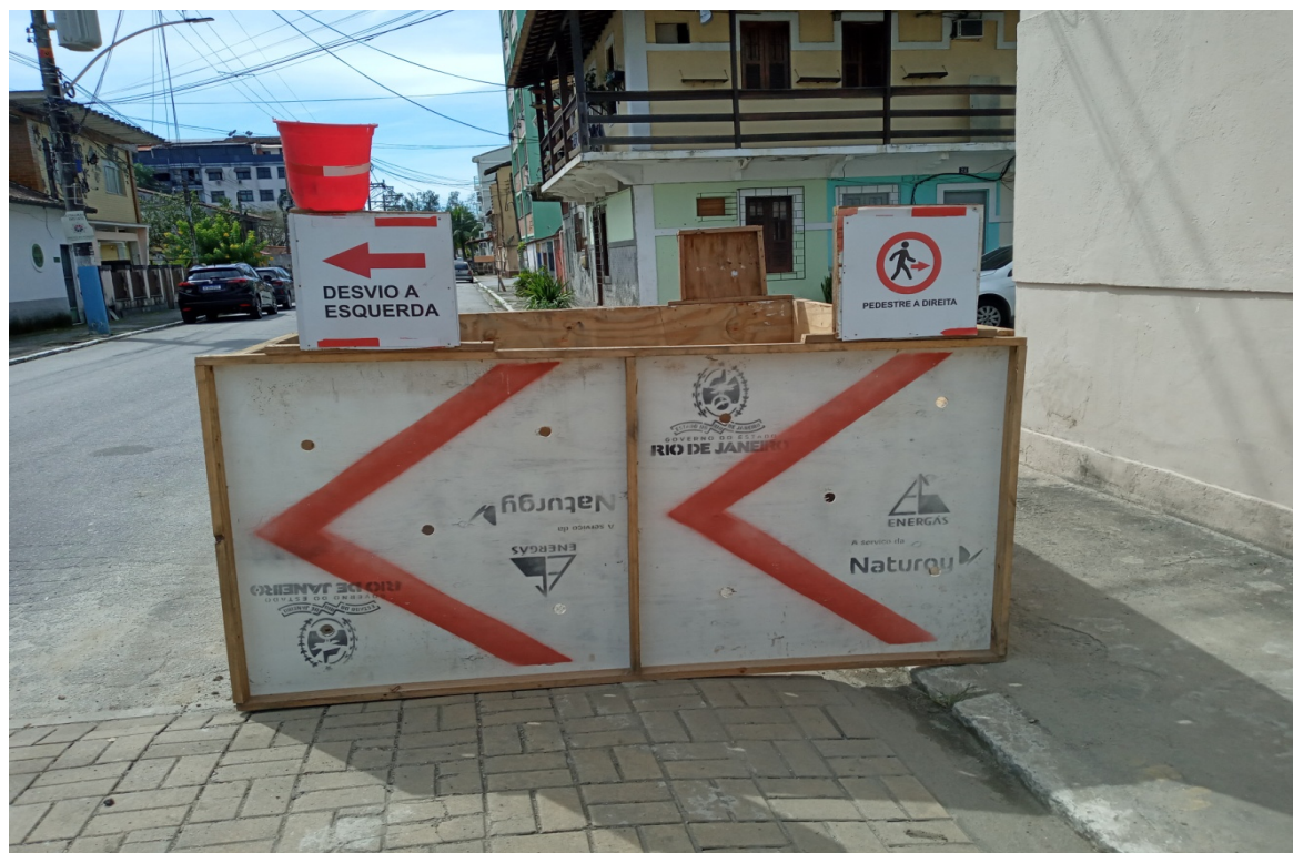
Foto 2: Sinalização de desvio de trânsito e pedestre
