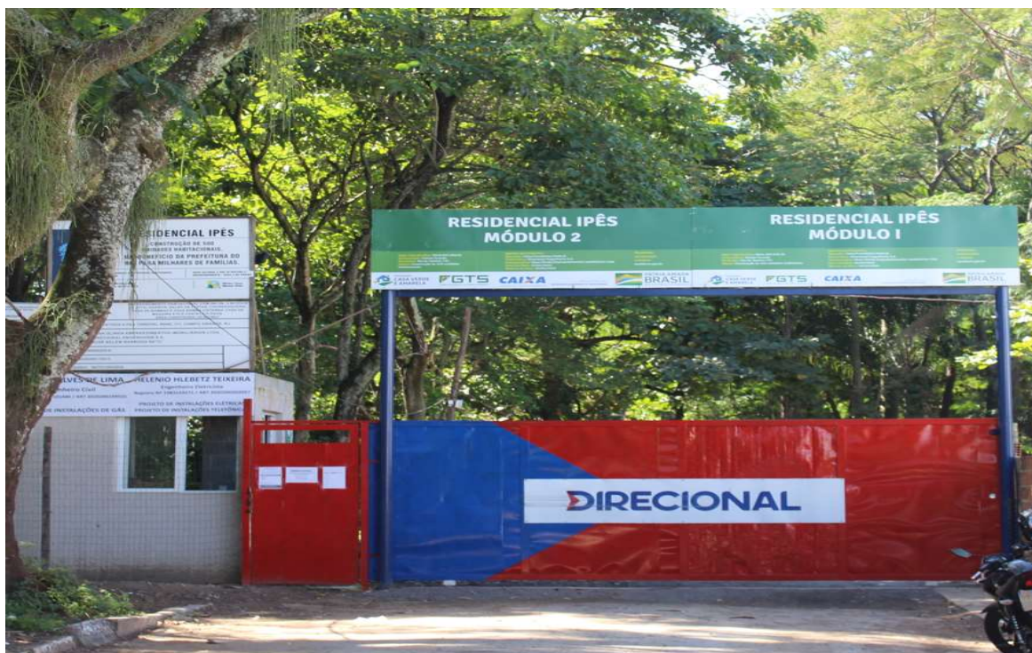
Foto 1 : fachada do condomínio
