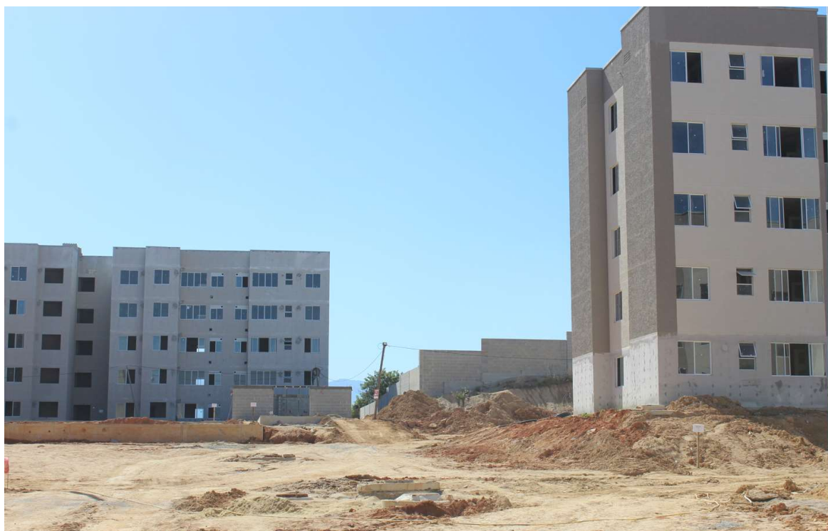
Foto 2 : situação atual das obras do condomínio
