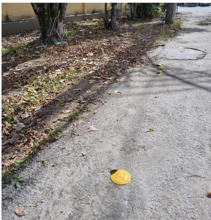
Foto 4: Trecho de assentamento de tubulação por método não destrutivo identificado com marco plano.
