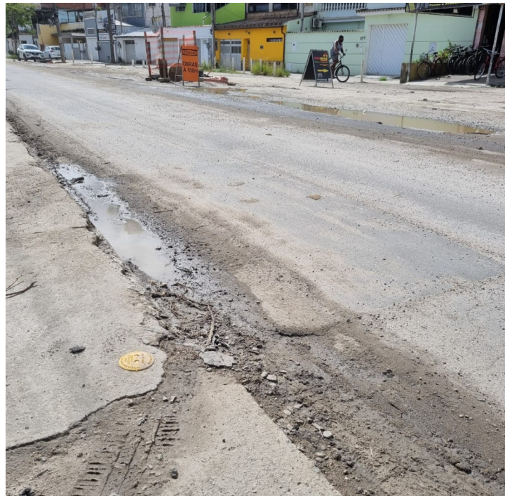
Foto 6: Trecho do Tie-in na via recomposto definitivamente + marco plano na calçada.
