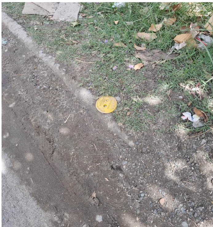
Foto 3: Trecho de assentamento de tubulação por método não destrutivo identificado com marco plano.
