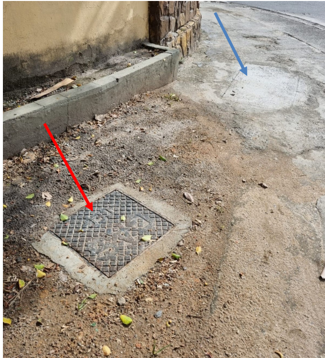
Foto 1: Válvula de segurança instalada na área da interligação da nova rede da Estrada do Moinho com a existente na Estrada da Cachamorra (seta vermelha) + trecho de recomposição no passeio (seta azul).
