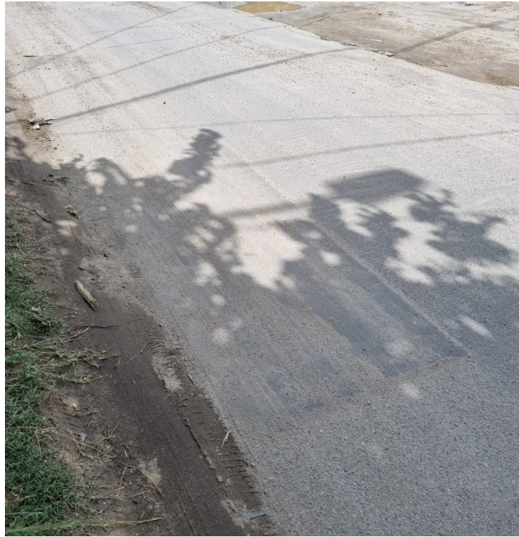
Foto 5: Trecho do Tie-in na via recomposto definitivamente.
