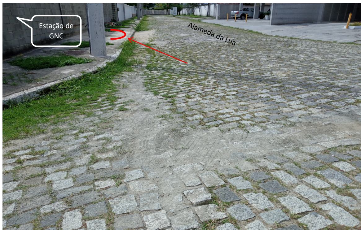
Foto 1: Ponto de início da obra (Fase 1)
