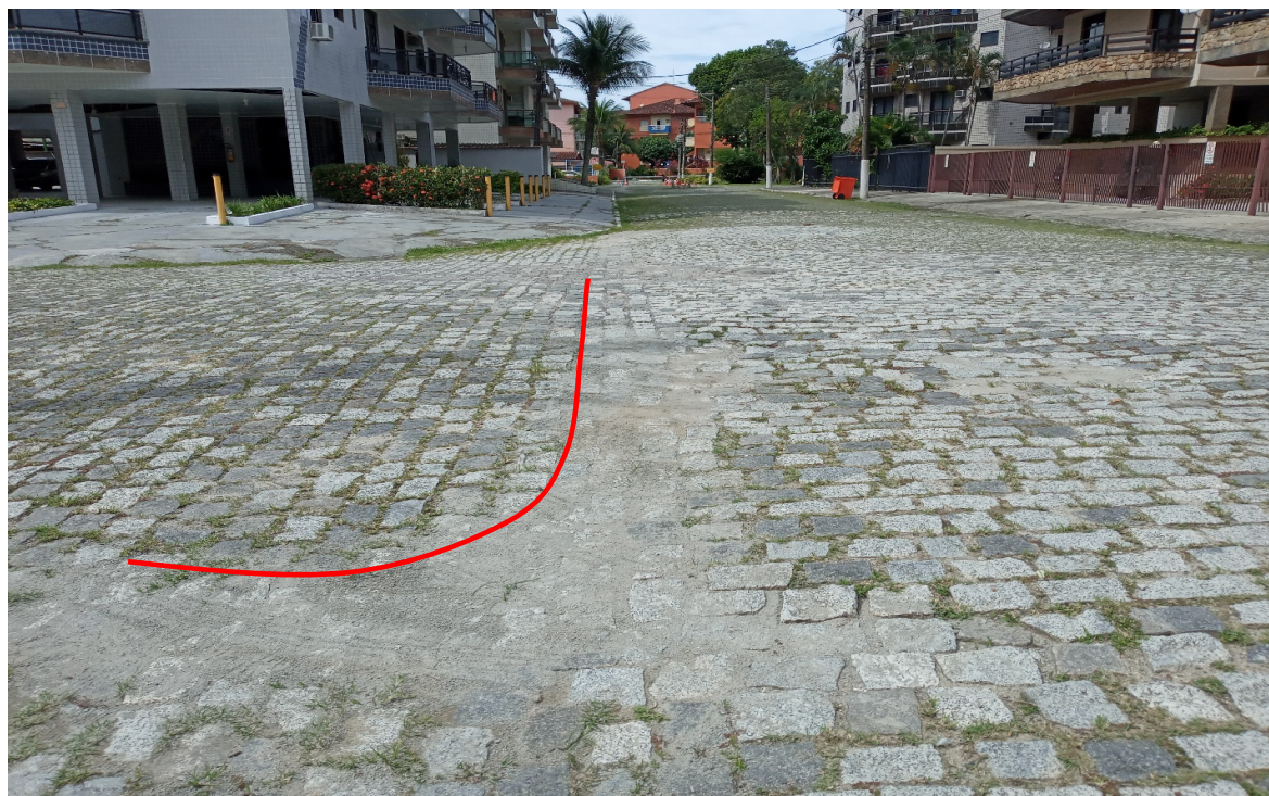
Foto 7: Recomposição de calçamento em travessia de rede
