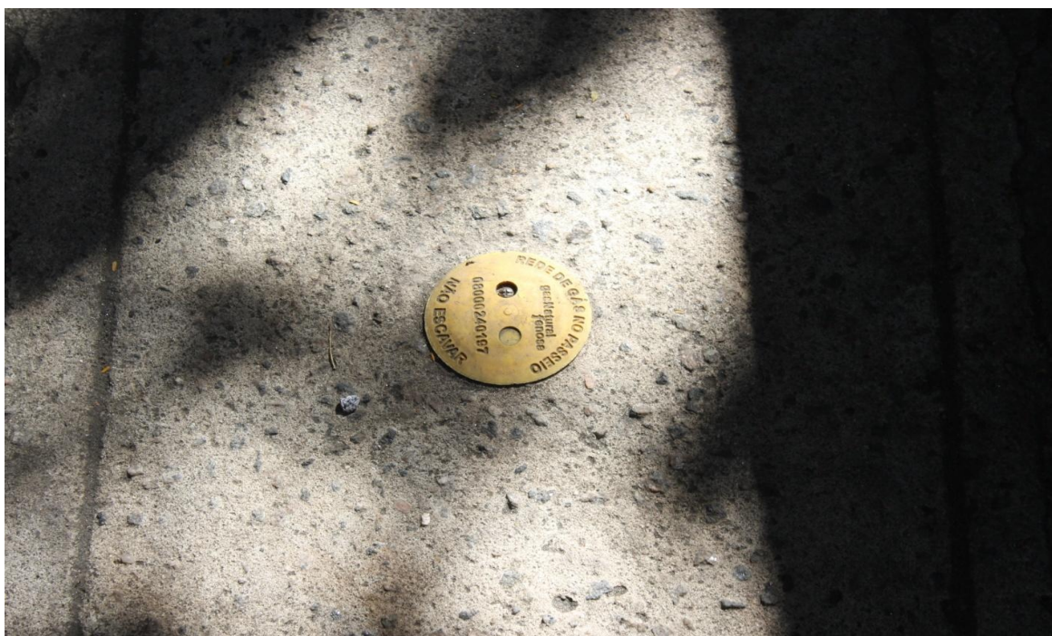
Foto 4: Marco Plano indicando a presença de Rede Gás Natural.
