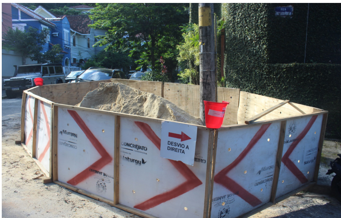
Foto 6: Armazenamento de material, isolamento e sinalização
