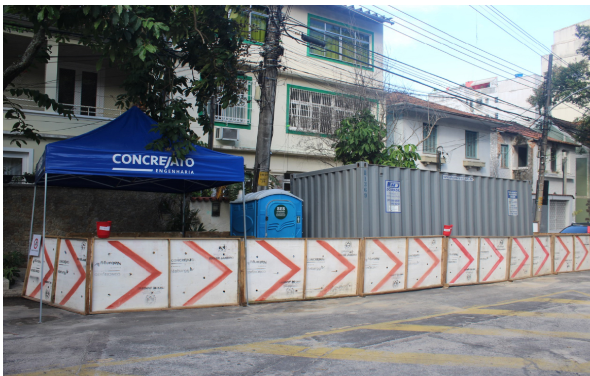
Foto 4: Área de vivência, isolamento e sinalização
