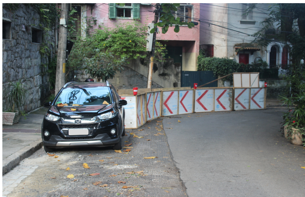
Foto 2: Área tapumada e asfalto fresado
