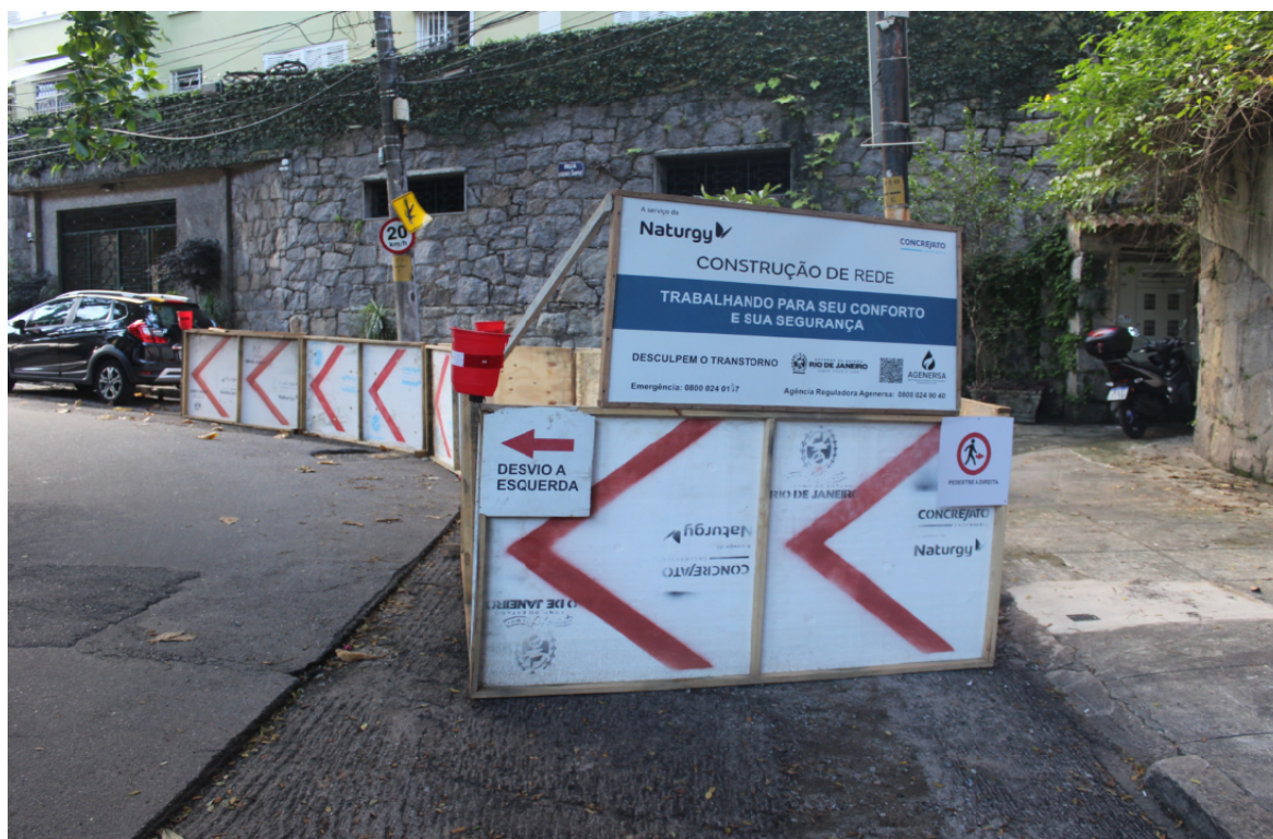
Foto 1: Identificação da obra, sinalização e isolamento
