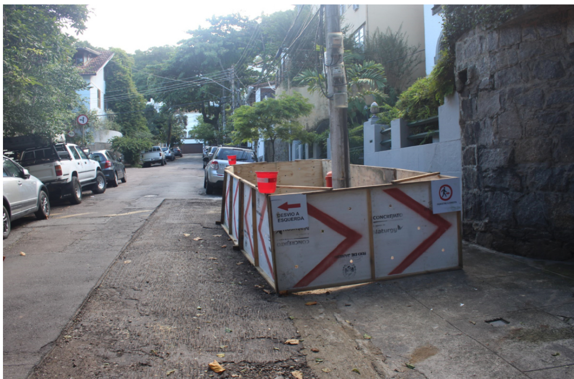
Foto 3: Isolamento e sinalização
