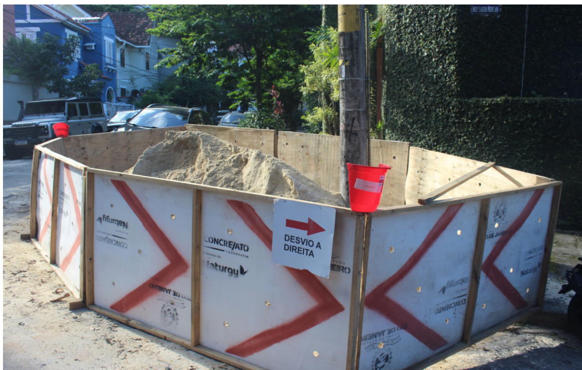
Foto 6: Armazenamento de material e sinalização
