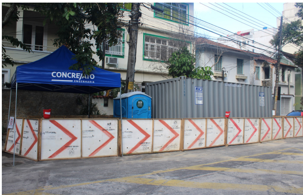
Foto 4: Área de vivência, sinalização e isolamento
