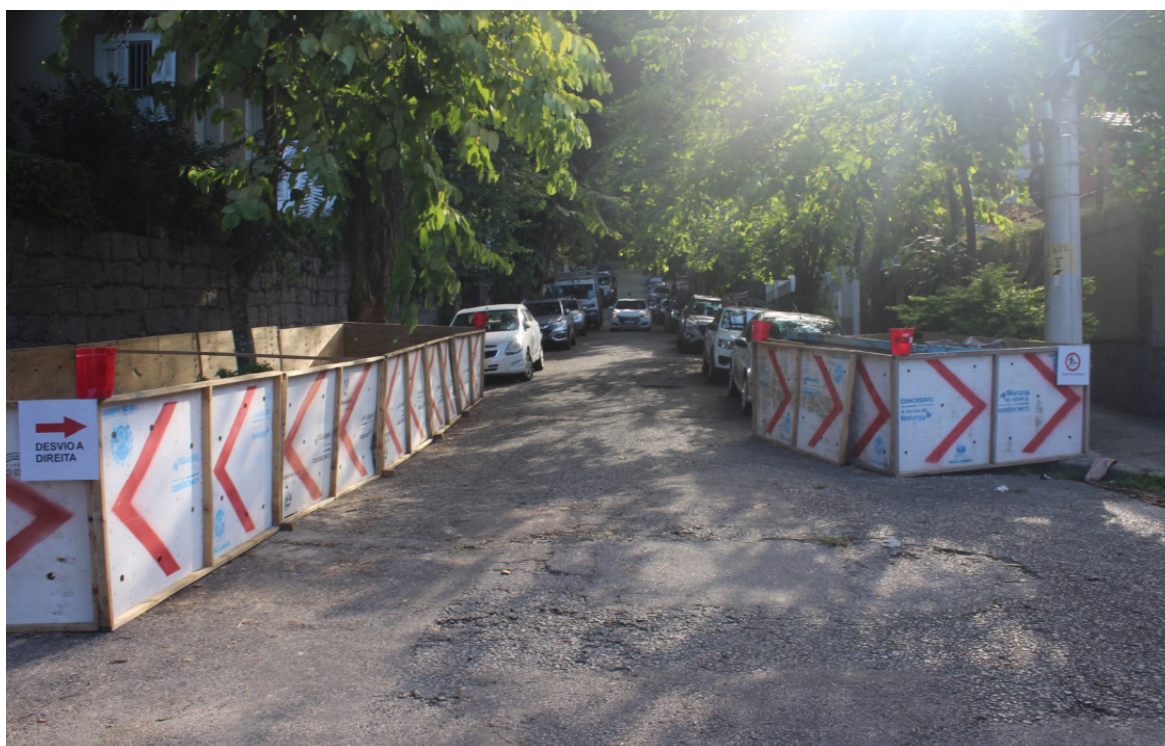
Foto 8: Isolamento e sinalização
