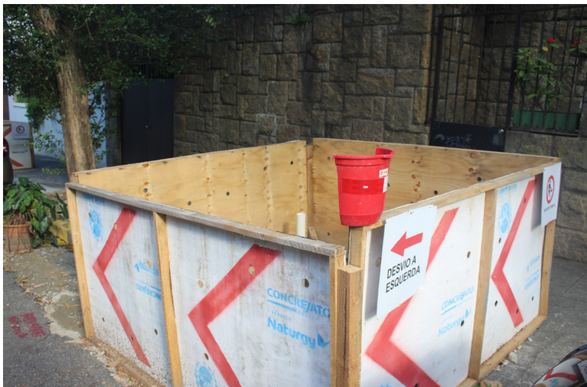
Foto 7: Isolamento e sinalização
