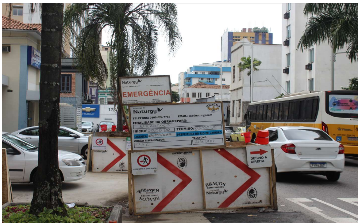
Foto 1 : identificação da obra na Rua Real Grandeza
