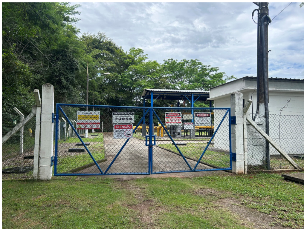
Foto 1: Vista da entrada da estação de medição.
