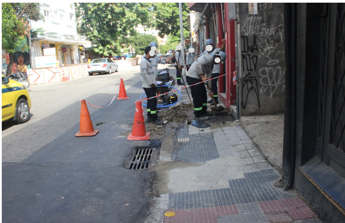
Foto 6: Recomposição e intervenção da equipe da Águas do Rio
