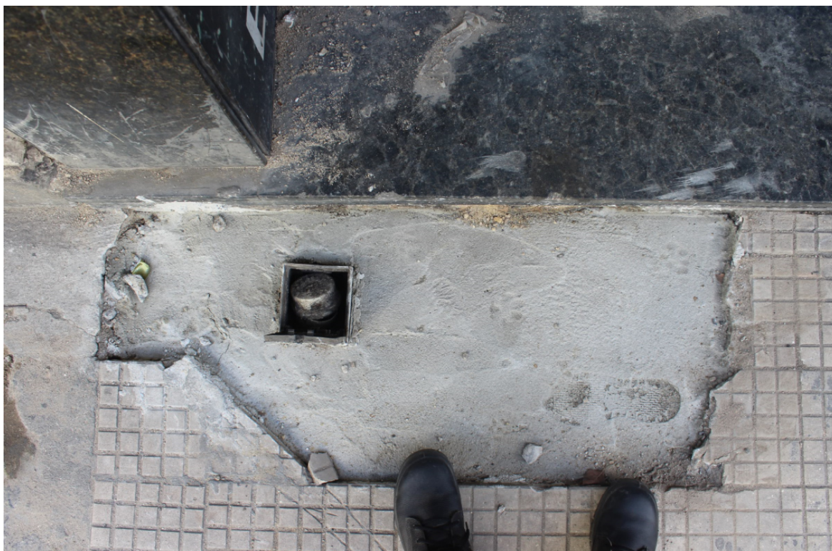
Foto 7: Intervenção na válvula
