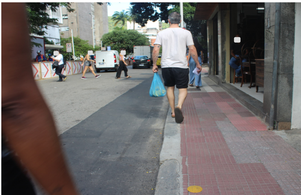
Foto 8: Recomposição e sinalização
