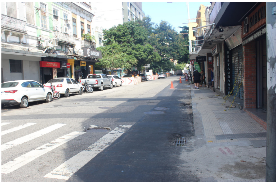
Foto 5: Recomposição de travessia, via e calçada
