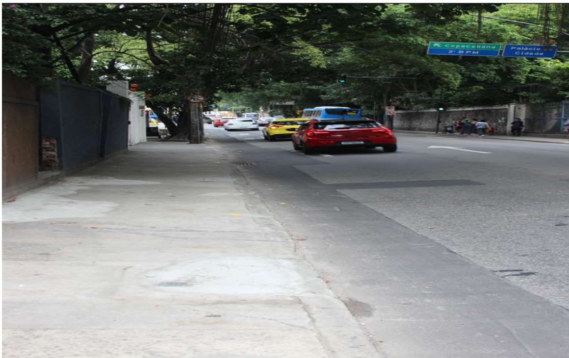
Foto 1 : recomposição na Rua São Clemente e marco plano
