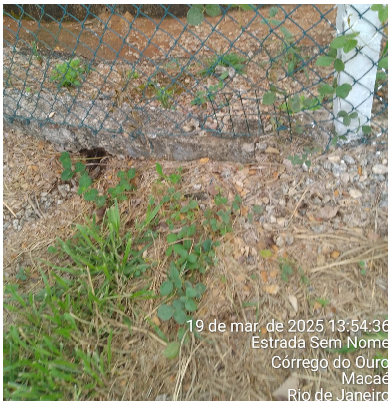
Foto 9: Falha na cerca reparada.
