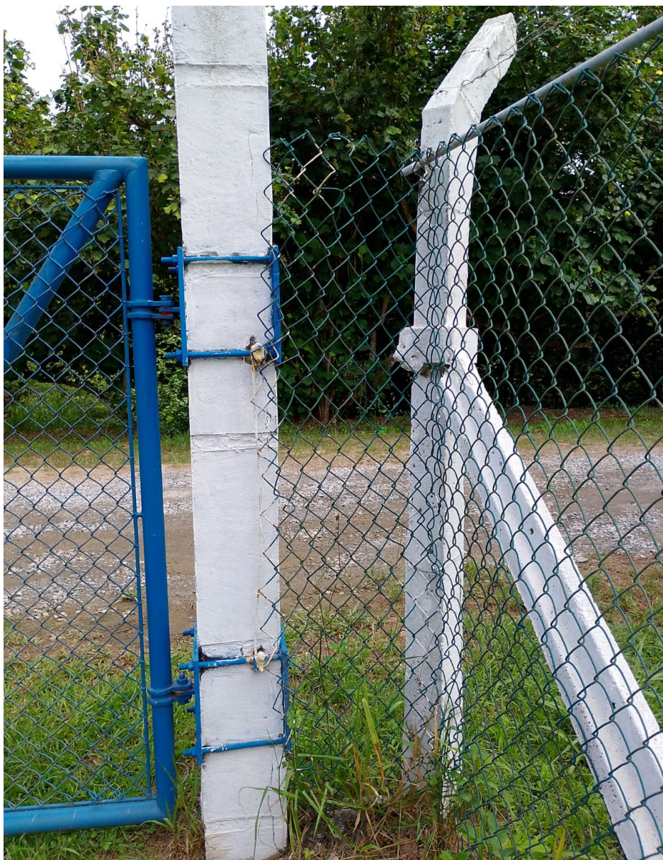
Foto 11: Falha na cerca reparada.
