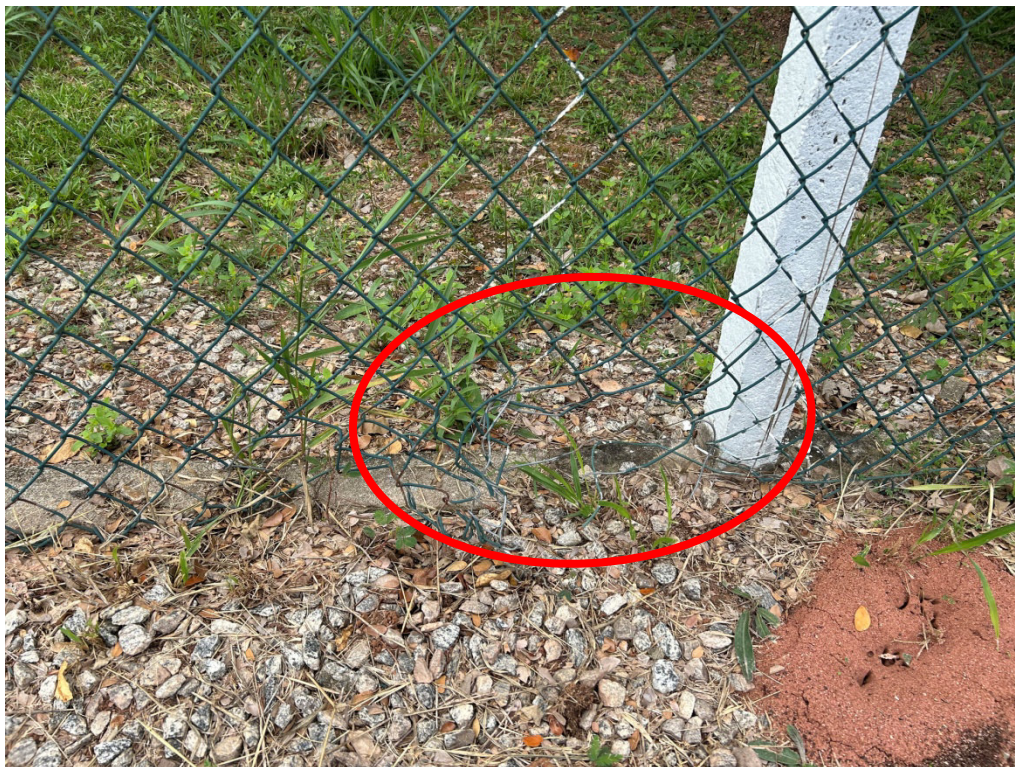
Foto 7: Falha visível na cerca.
