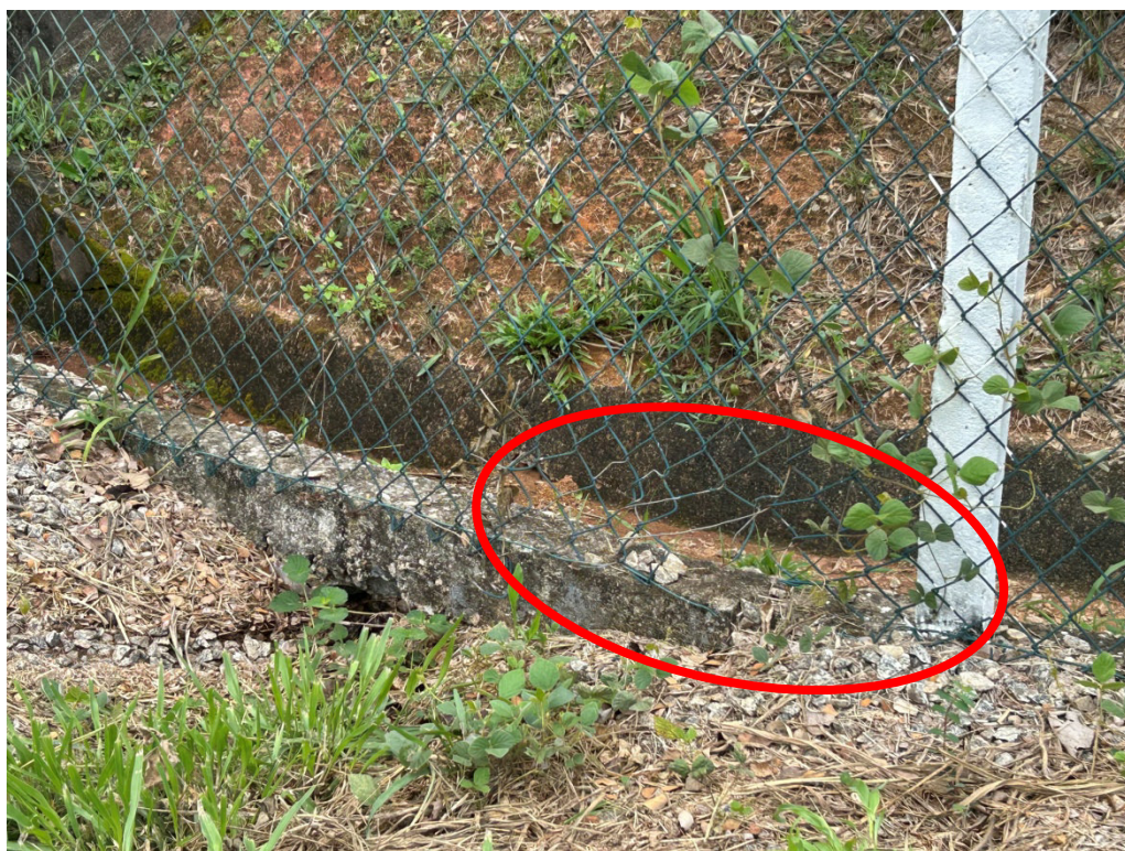
Foto 6: Falha visível na cerca.
