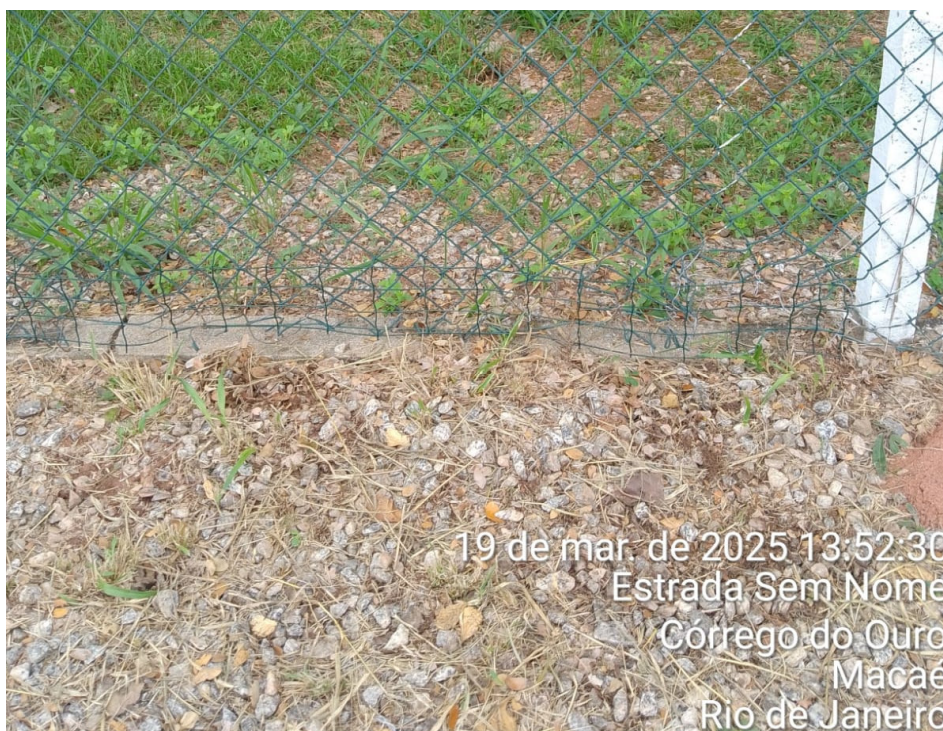
Foto 10: Falha na cerca reparada.
