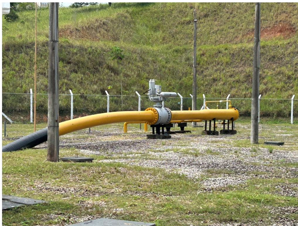
Foto 2: Canhão receptor de PIG.
