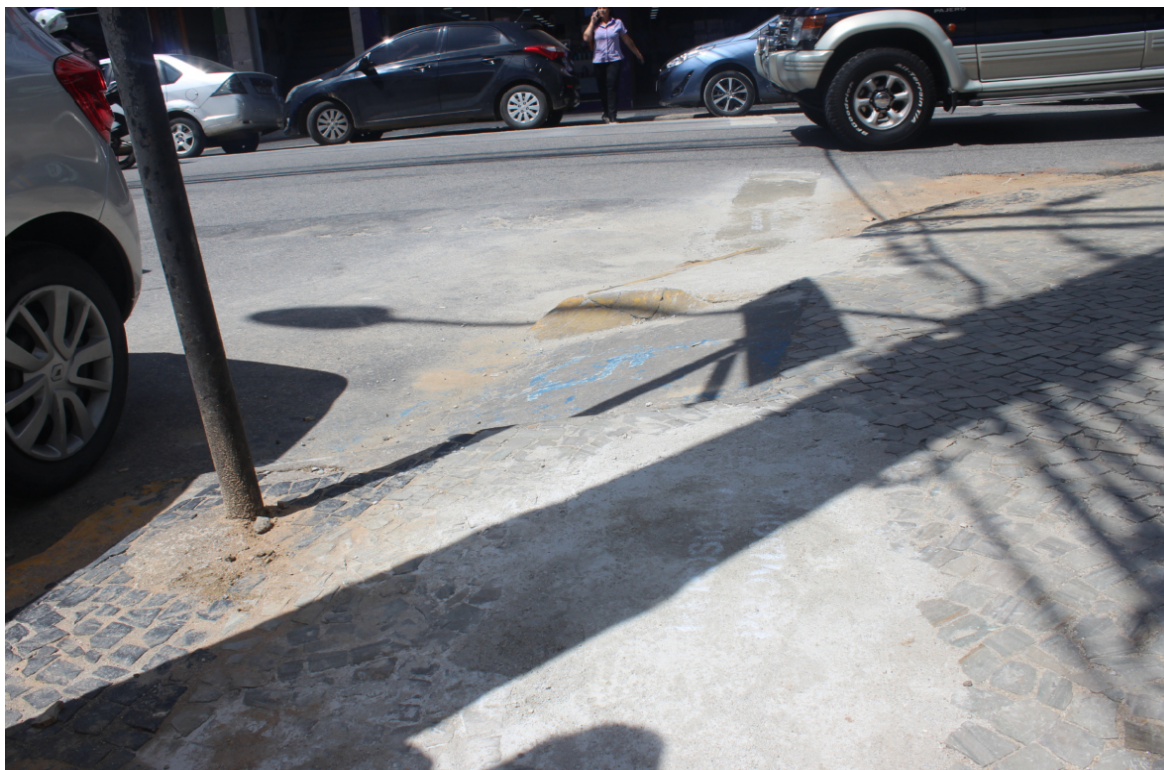
Foto 3: Recomposição provisória em trecho com dama para início da travessia
