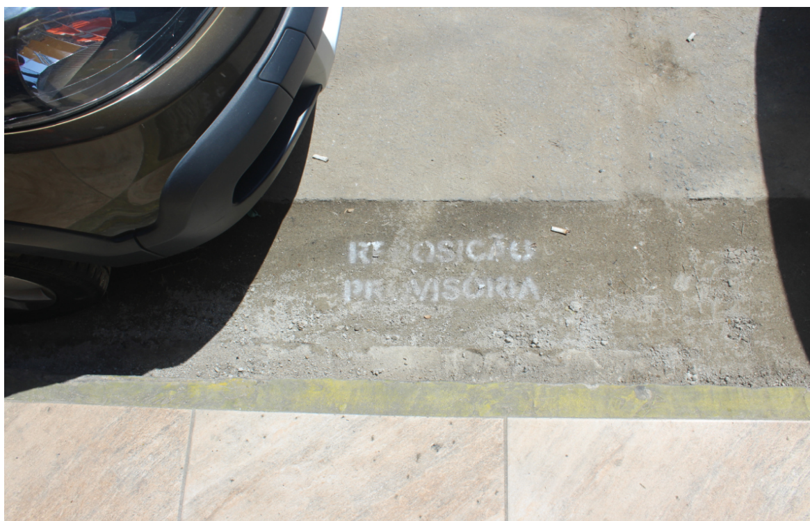
Foto 6: Recomposição provisória do assentamento na Avenida Delfim Moreira
