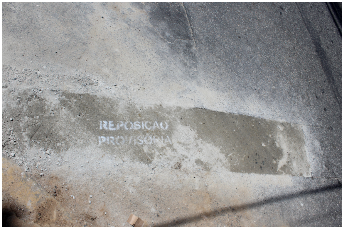
Foto 5: Travessia com recomposição provisória
