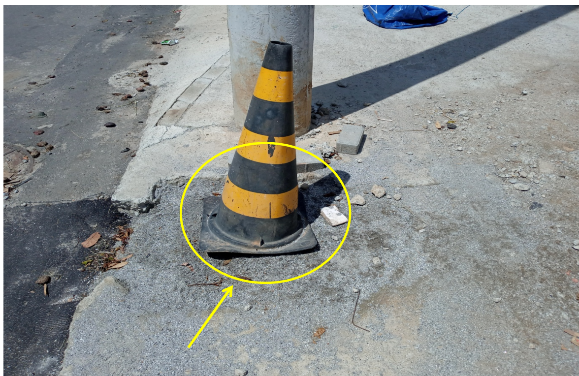
Foto 2: Válvula de rede
