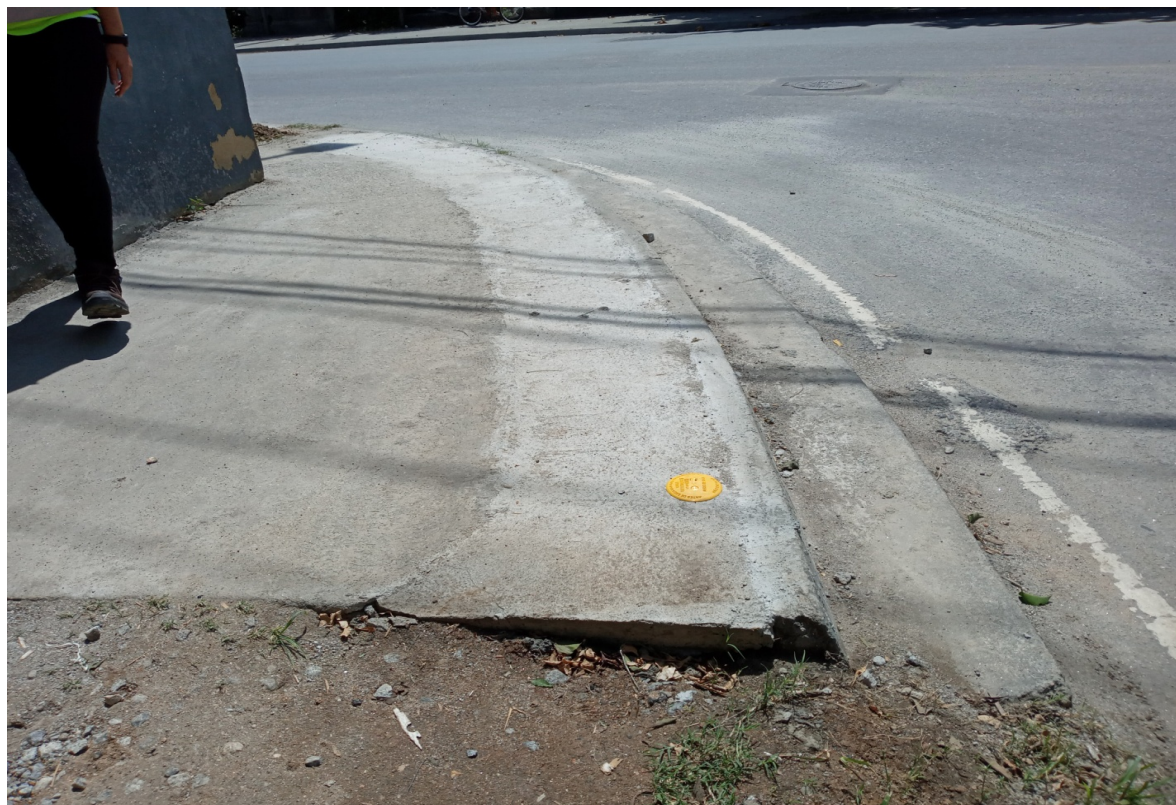
Foto 4: Recomposição da calçada
