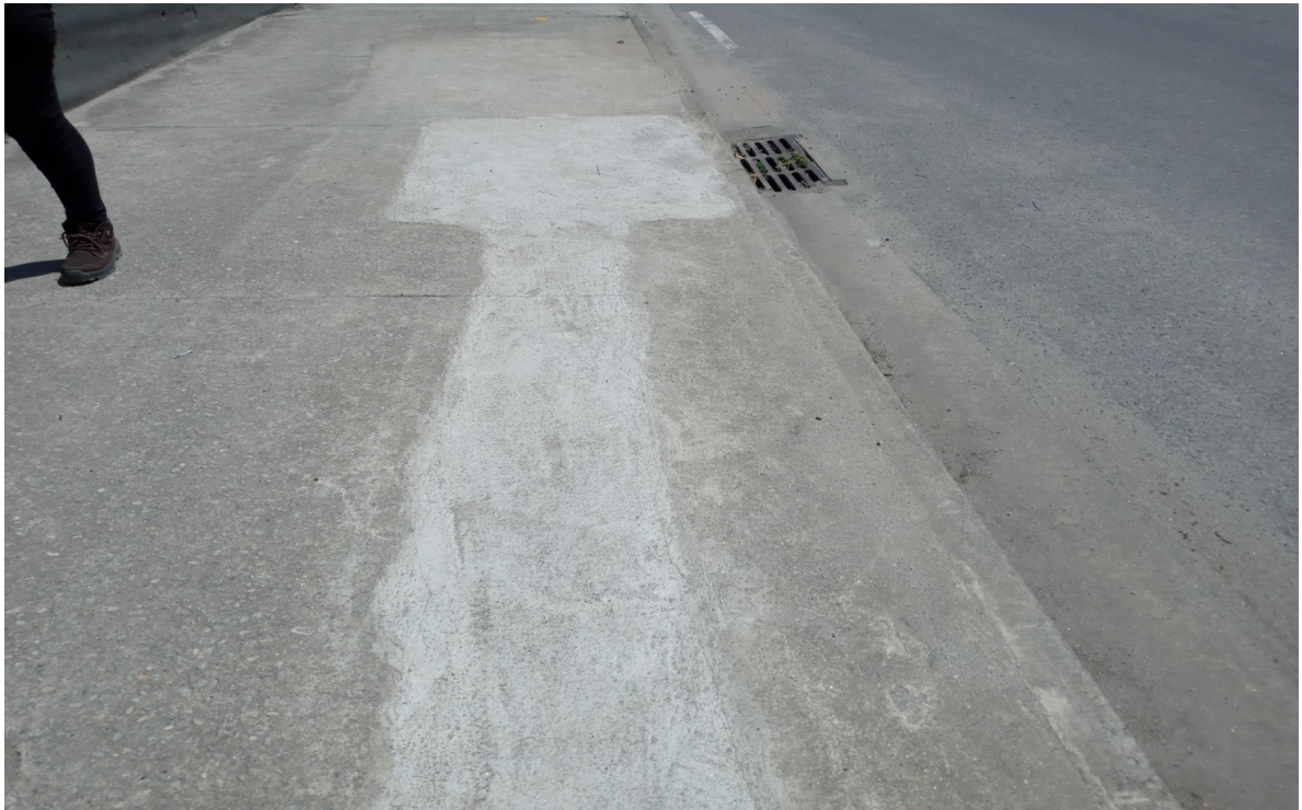
Foto 5: Recomposição da calçada
