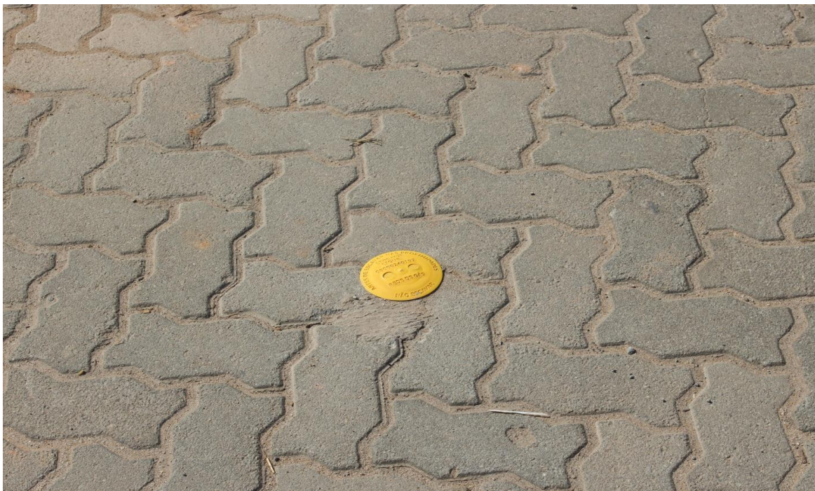
Foto 3: Marco Plano indicando a presença de Gás natural.
