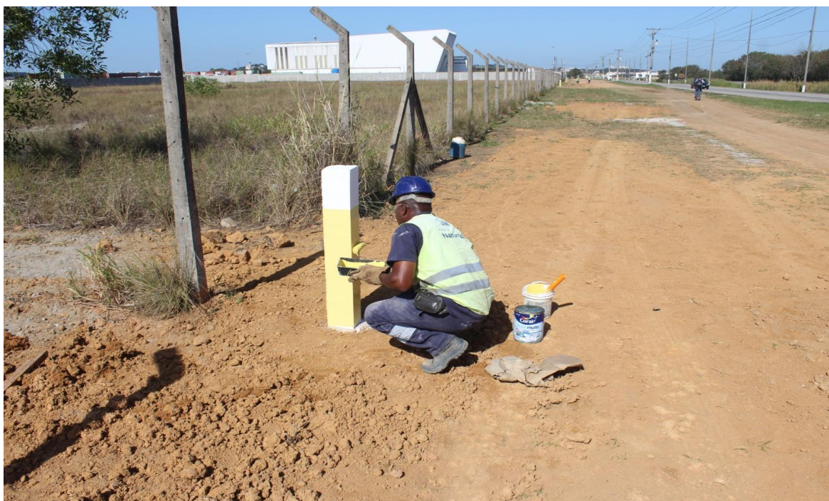
Foto 5: Funcionário realizando as marcações nos indicadores de rede horizontal.
