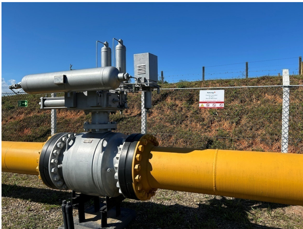
Foto 2: Canhão lançador de PIG para a UTE Mário Lago (Macaé Merchant) e placa de identificação (ao fundo).
