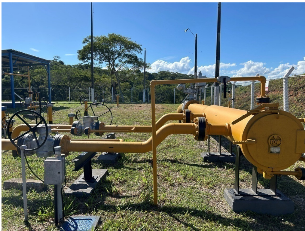
Foto 3: Canhão lançador de PIG para a UTE Mário Lago (Macaé Merchant).
