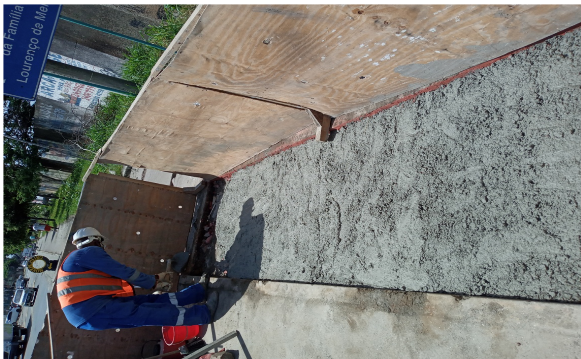
Foto 5: Funcionário executando serviço de recomposição da calçada
