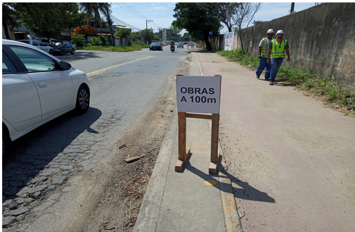
Foto 2: Aviso de obra à frente (Estrada da Urucânia)
