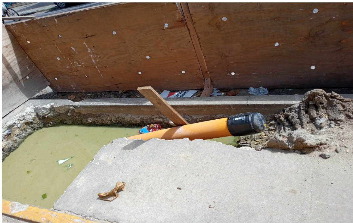
Foto 17: Rede a ser conectada (tie in com líquido acumulado - antes)
