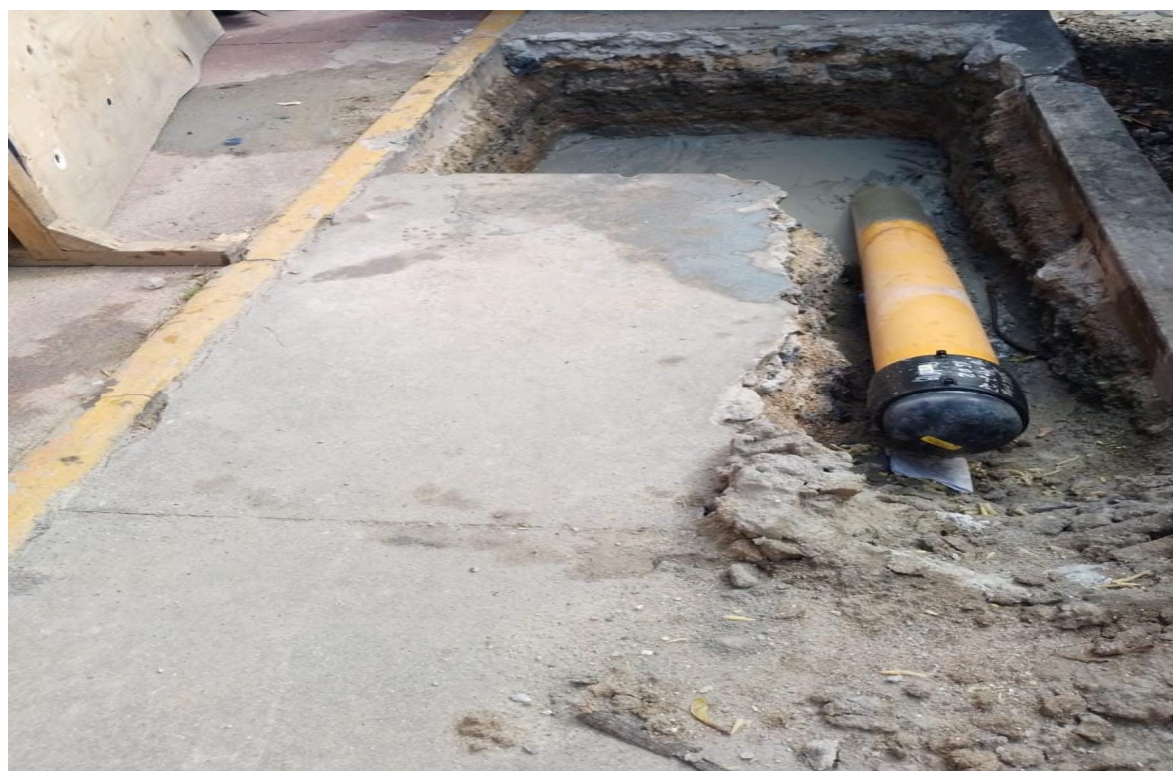
Foto 18: Rede a ser conectada (tie in com líquido acumulado - depois)
