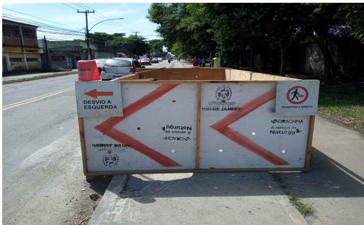
Foto 3: Isolamento e sinalização noturna
