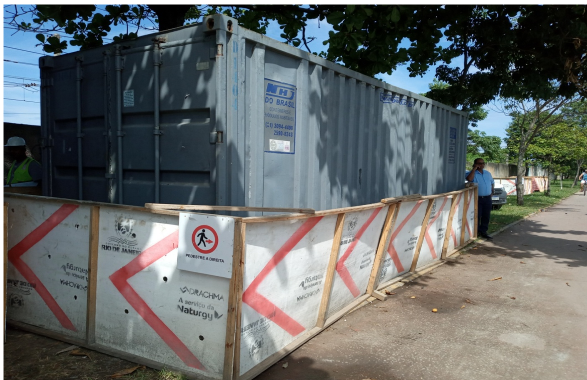
Foto 10: Armazenamento de material
