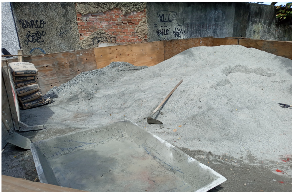
Foto 12: Armazenamento de material
