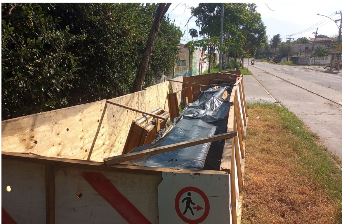
Foto 12: Isolamento inefficiente (depois)
