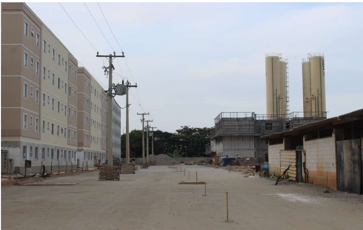
Foto 2 : situação atual das obras do condomínio
