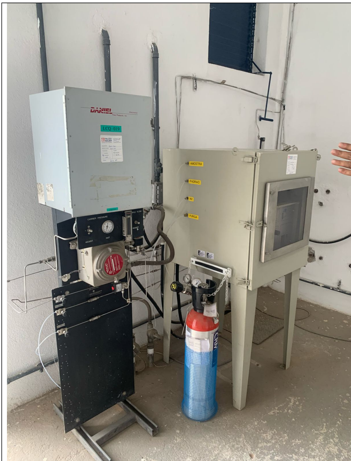
Foto 3: Sistema de cromatografia da estação.
