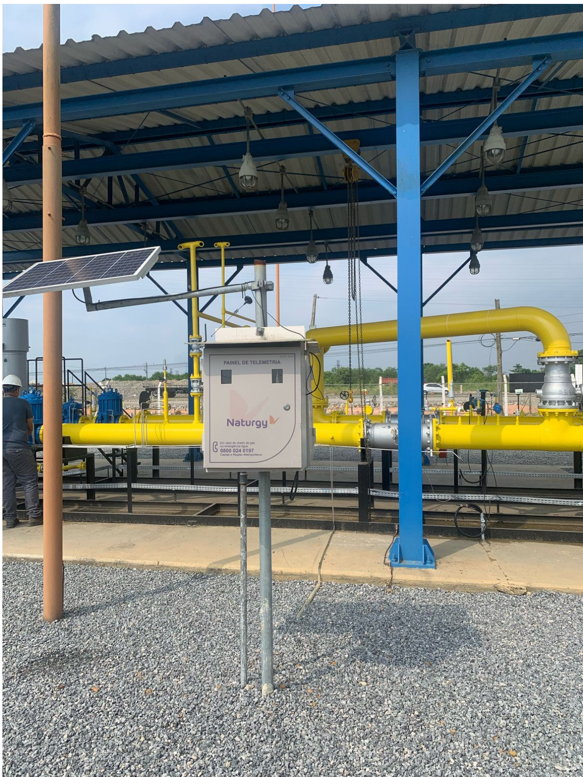
Foto 12: Painel de Telemetria da estação.
