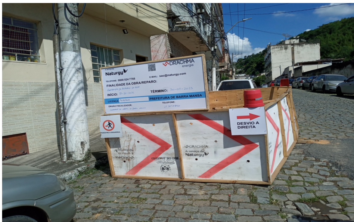
Foto 1: Identificação de obra
