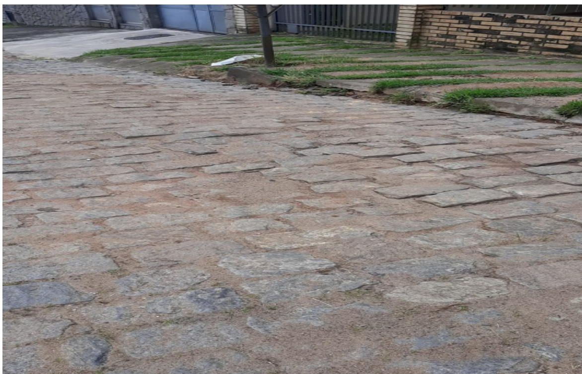
Foto 16: Recomposição de calçamento irregular (depois)
