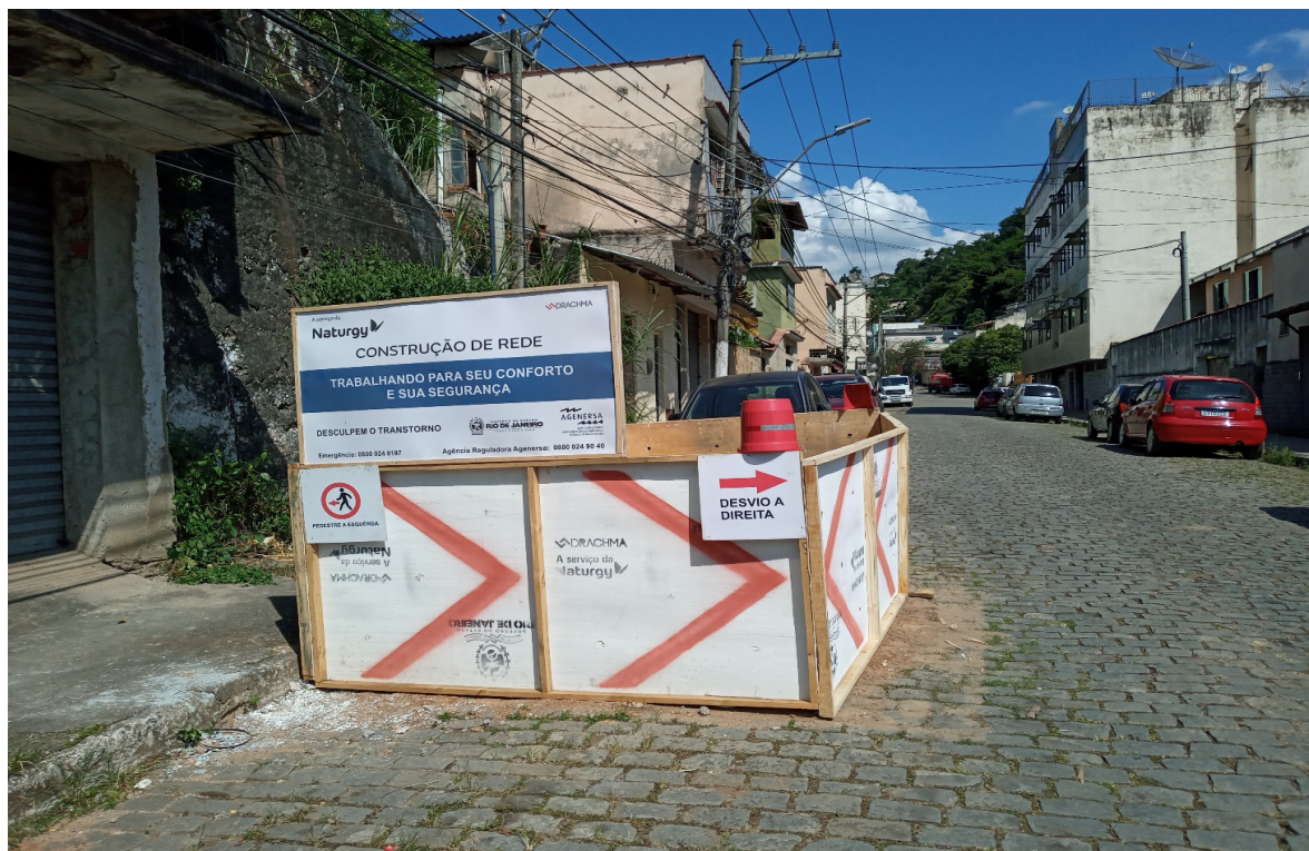
Foto 2: Sinalização de desvio de trânsito e pedestre
