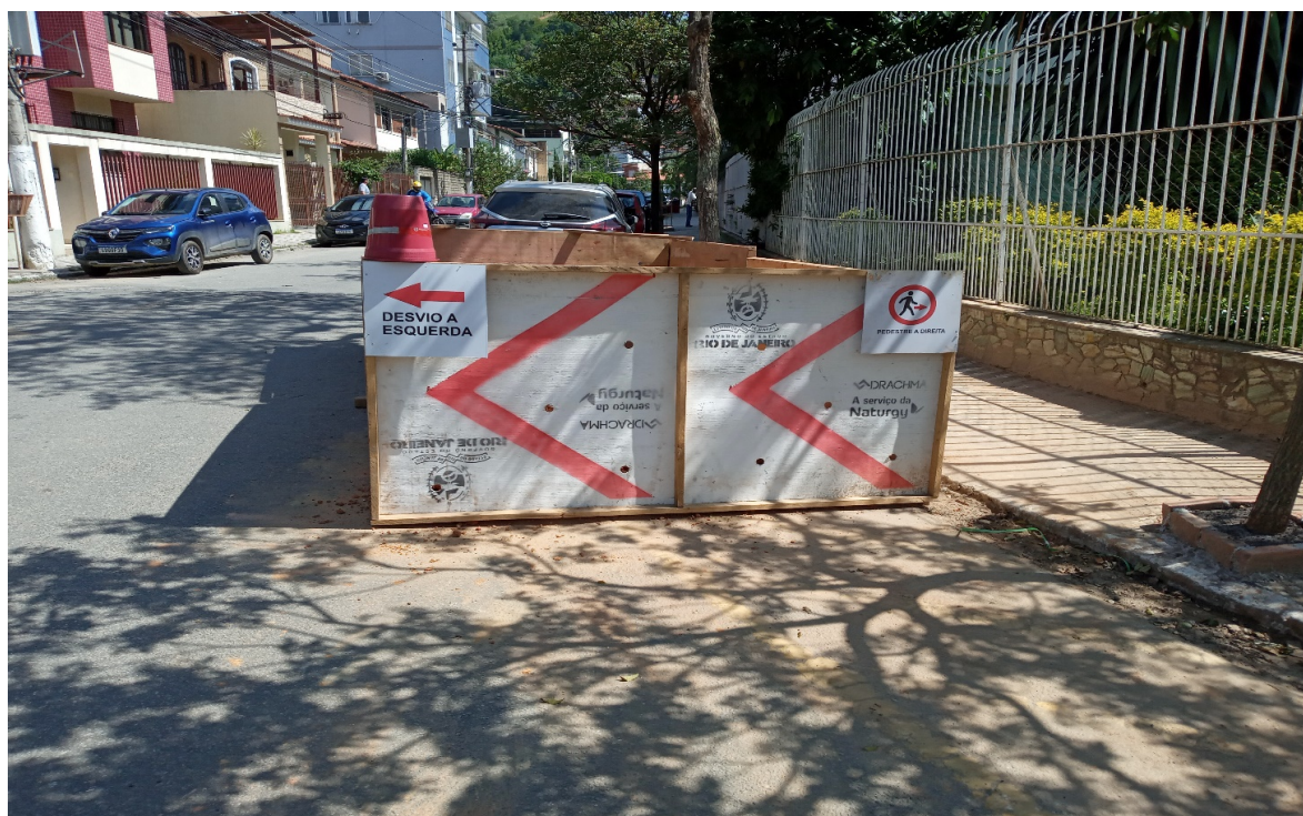
Foto 11: Sinalização e isolamento de obra.
