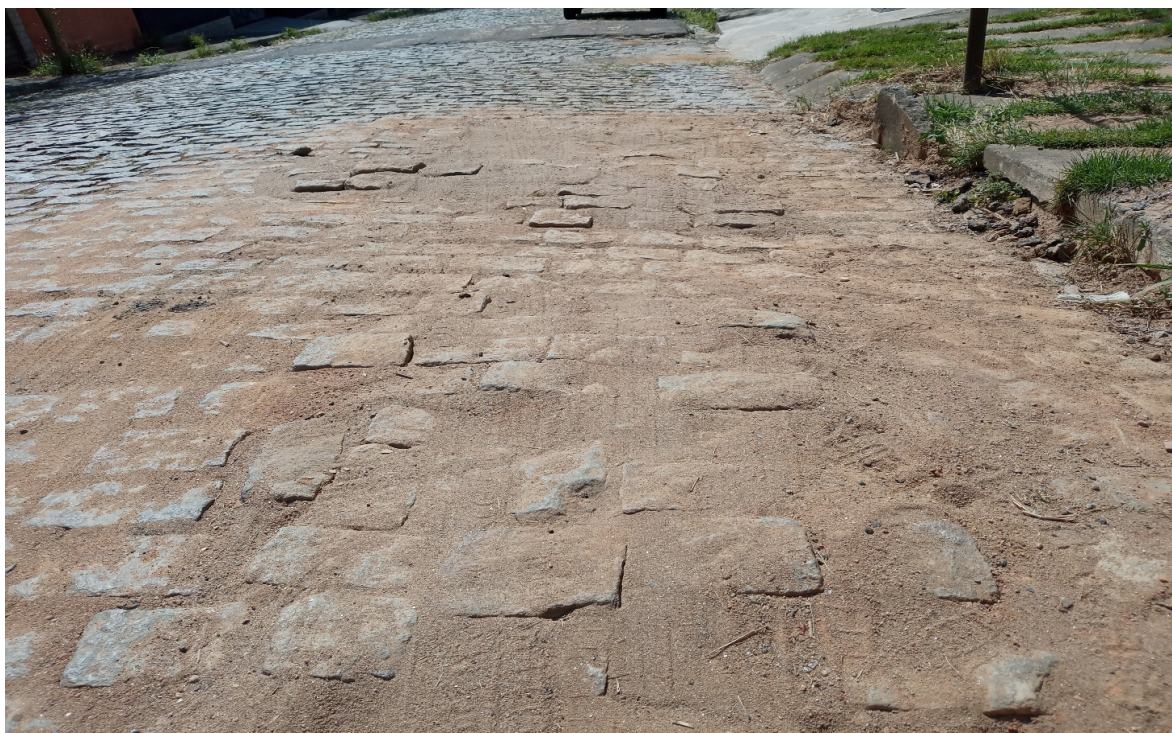
Foto 15: Recomposição de calçamento irregular (antes)
