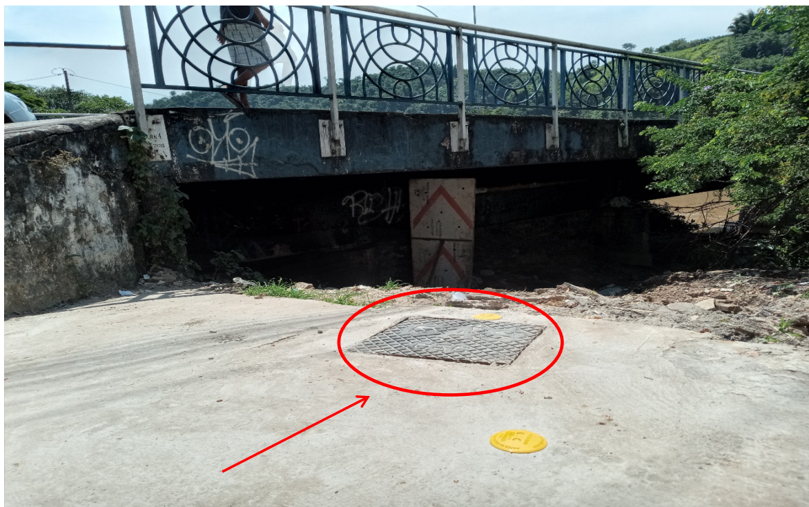
Foto 9: Ponto de interligação à rede existente e caixa de válvula de rede
