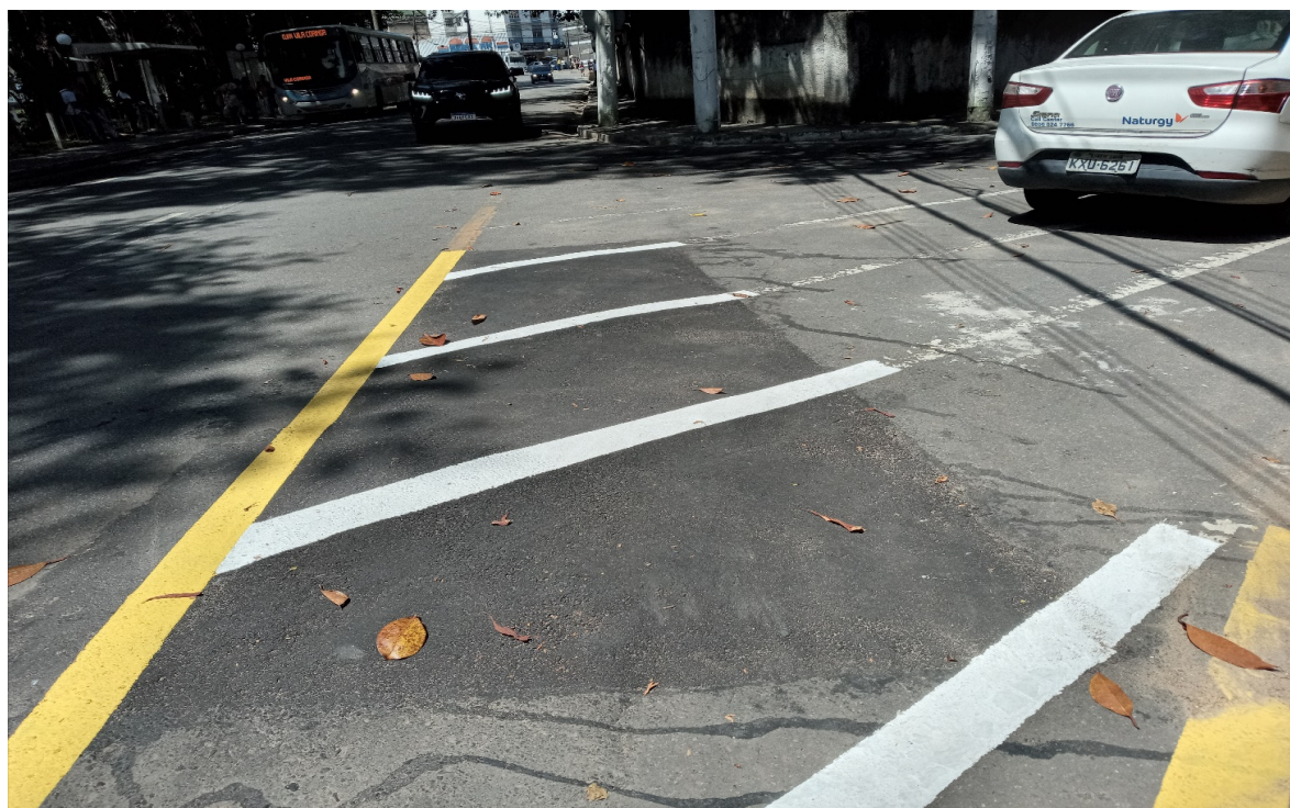
Foto 3: Recomposição de via e ponto de interligação à rede existente
