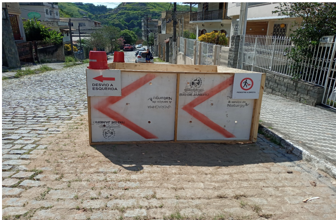
Foto 14: Isolamento de obra, desvio de trânsito e pedestre
