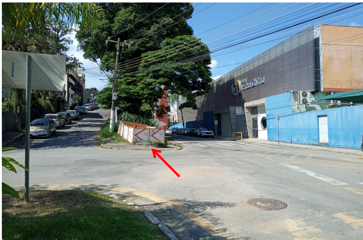
Foto 10: Ponto de interligação de rede (isolamento de obra)
