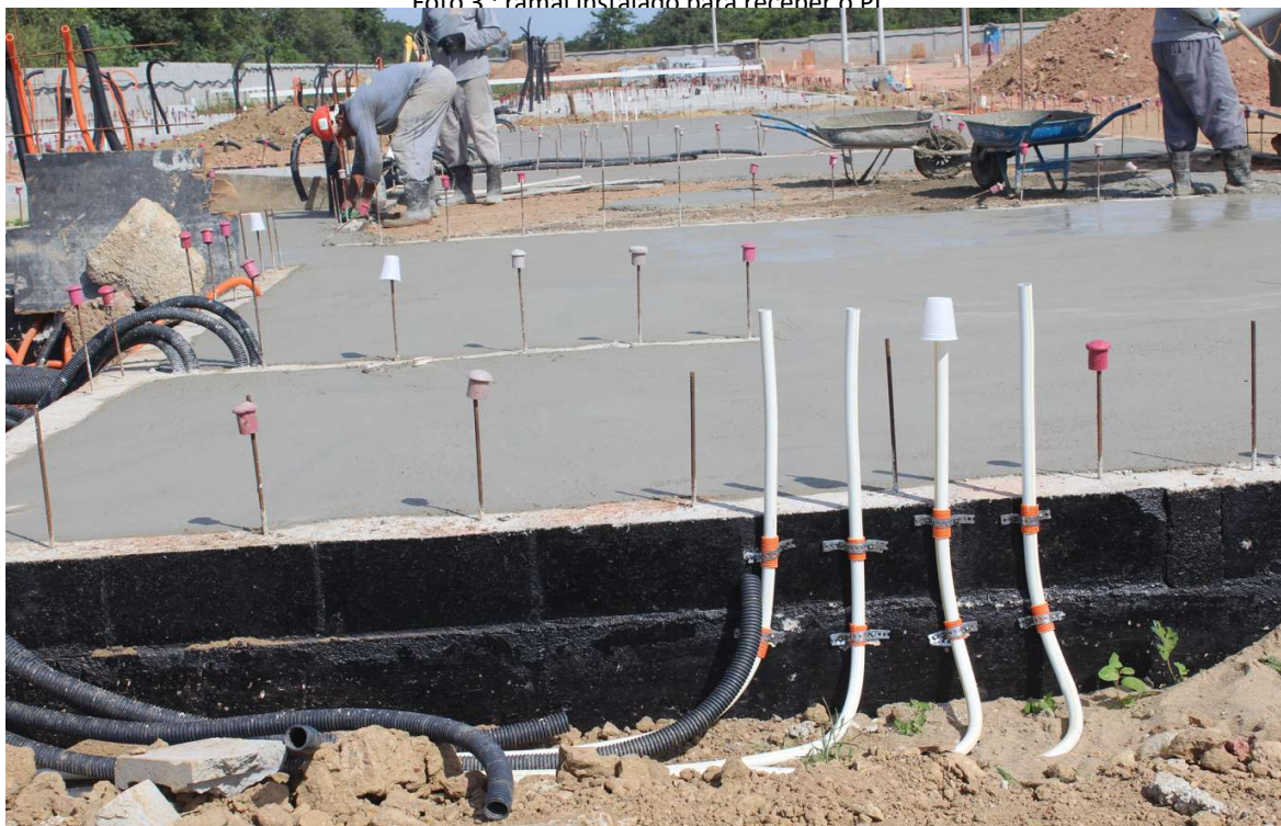
Foto 4 : instalação provisória em referência ao futuro PI
