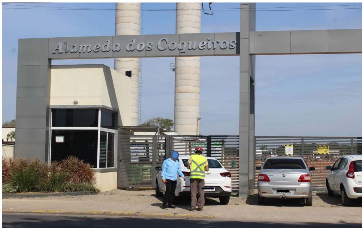
Foto 1 : fachada do condomínio
