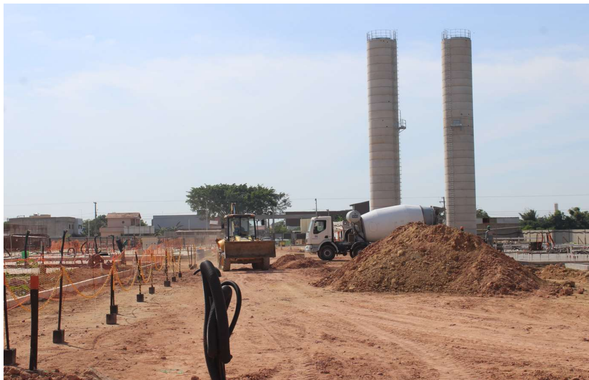
Foto 2 : situação atual das obras do condomínio
