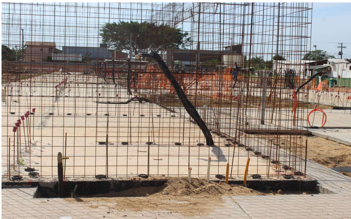
Foto 3 : ramal instalado para receber o PI
