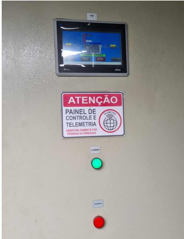
Foto 7: Sistema de controle e telemetria, com monitor de interface homem-máquina, da empresa Neogás.
