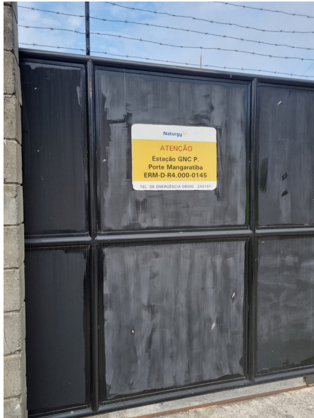
Foto 1: Placa de identificação da estação.
