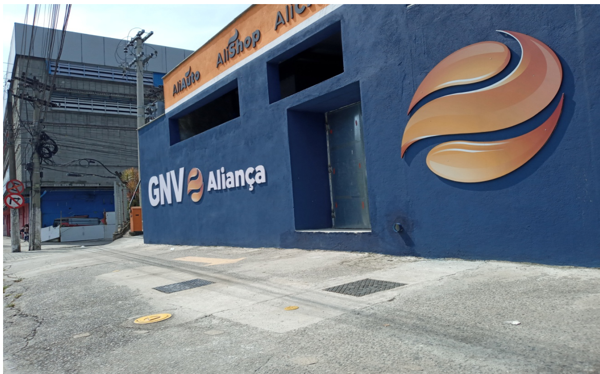
Foto 7: Caixa de válvula de ramal e de previsão de rede
