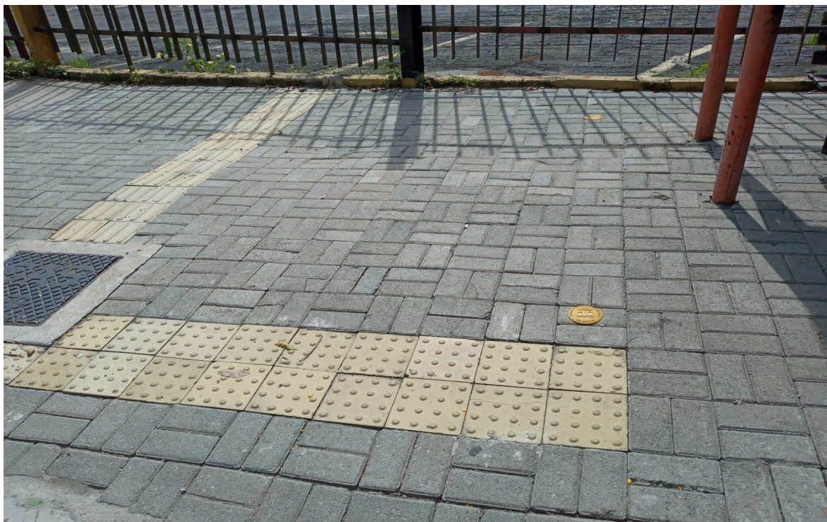
Foto 1: Recomposição de calçamento
