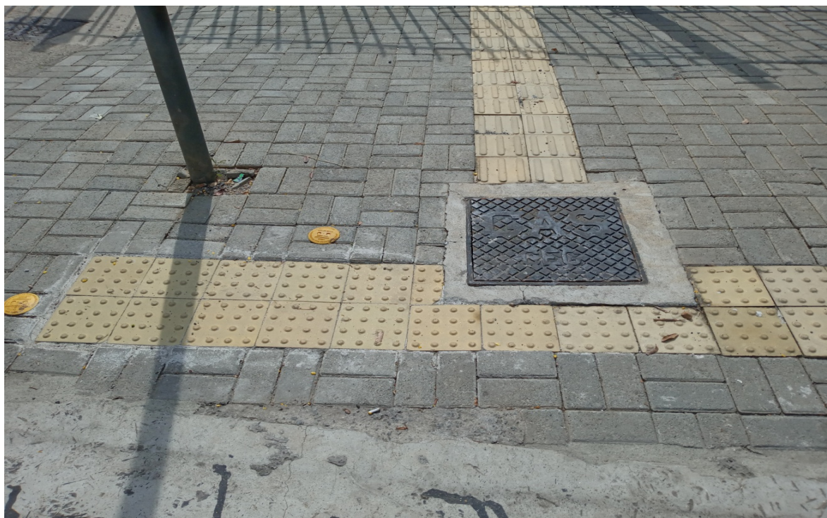
Foto 3: Caixa de válvula de rede
