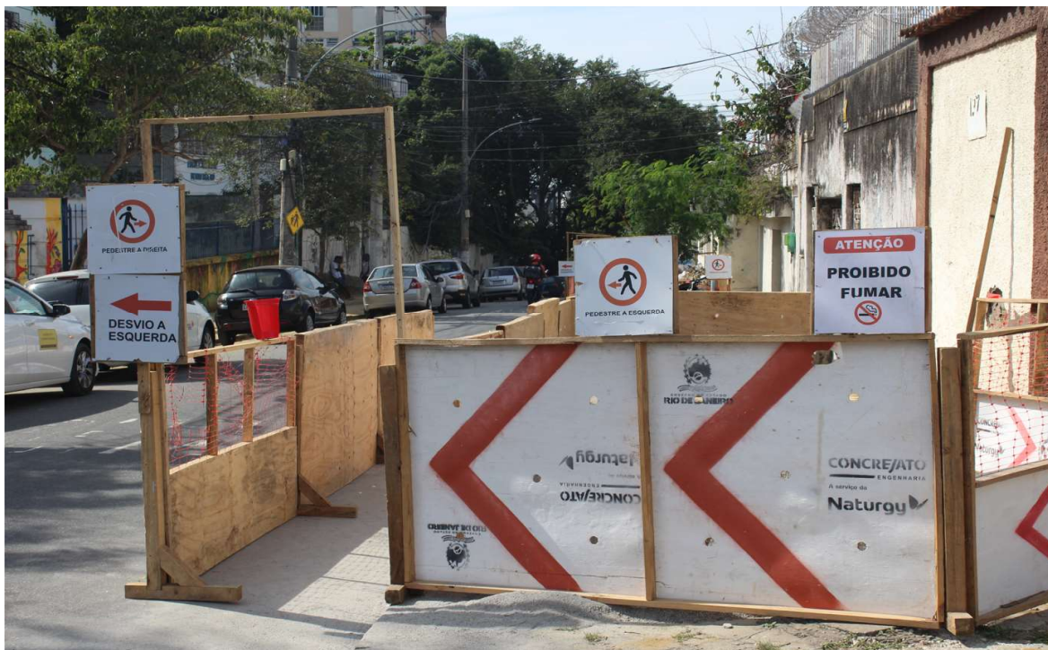
Foto 1 : renovação e expansão de rede na Rua Cônego Tobias
