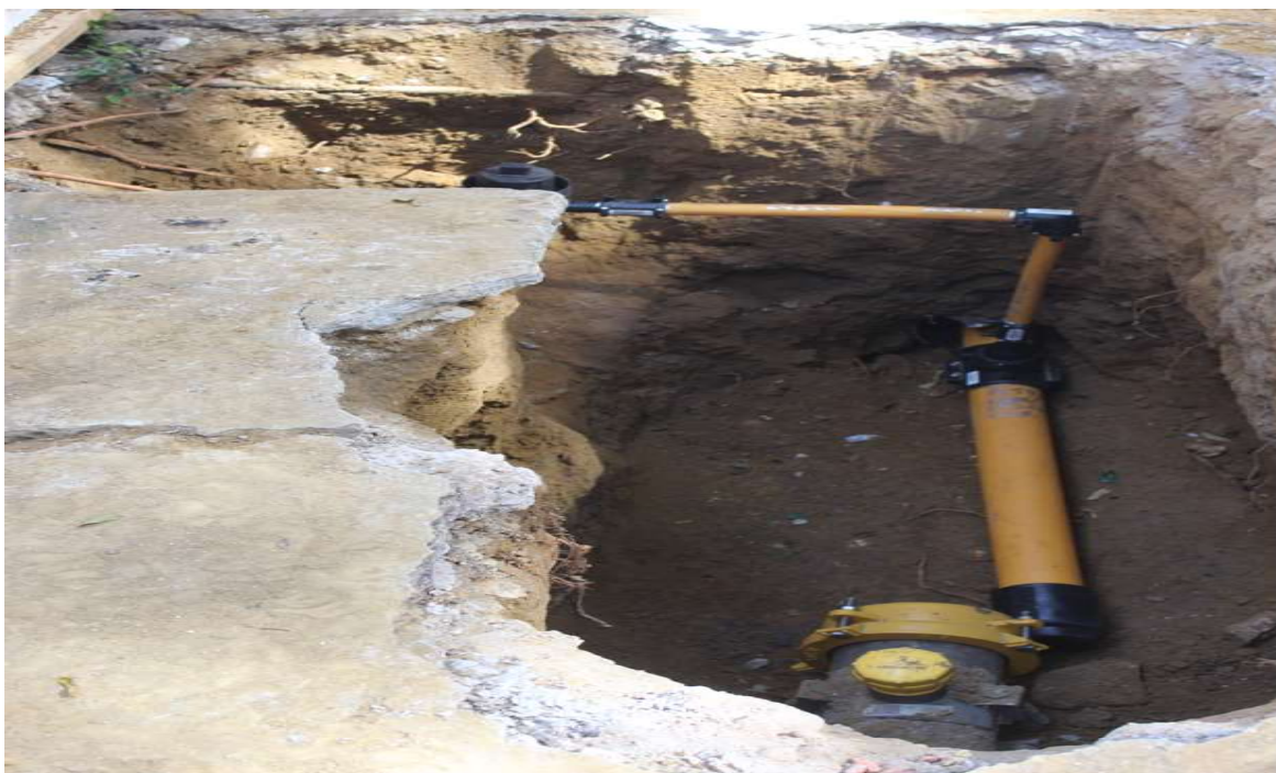
Foto 3 : inserção de rede de polietileno em ferro fundido
