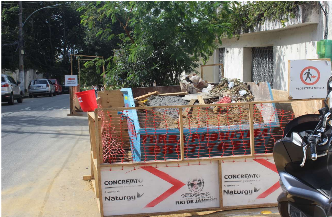
Foto 2 : local de descarte do material
