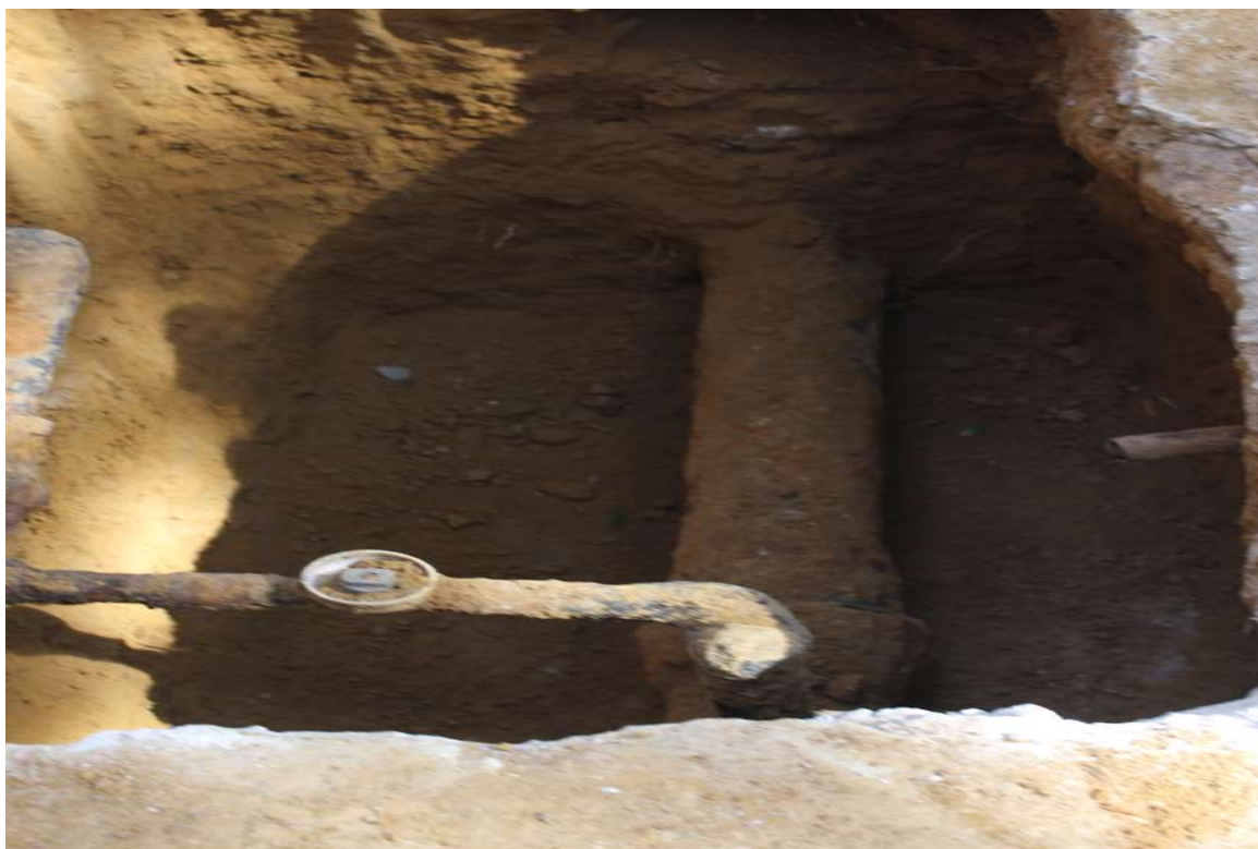
Foto 3 : inserção de rede de polietileno em ferro fundido
