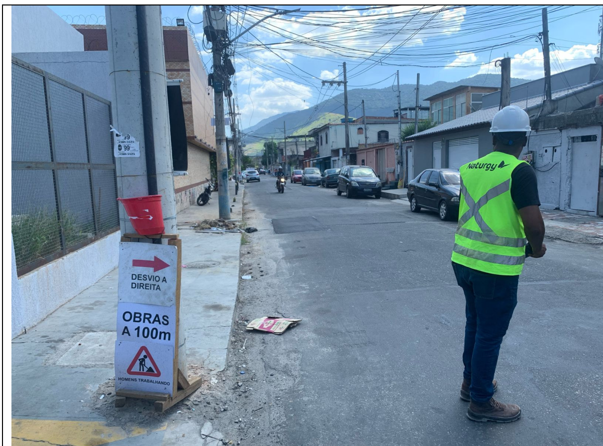
Foto 3: Placa de aviso de obra e de desvio.
