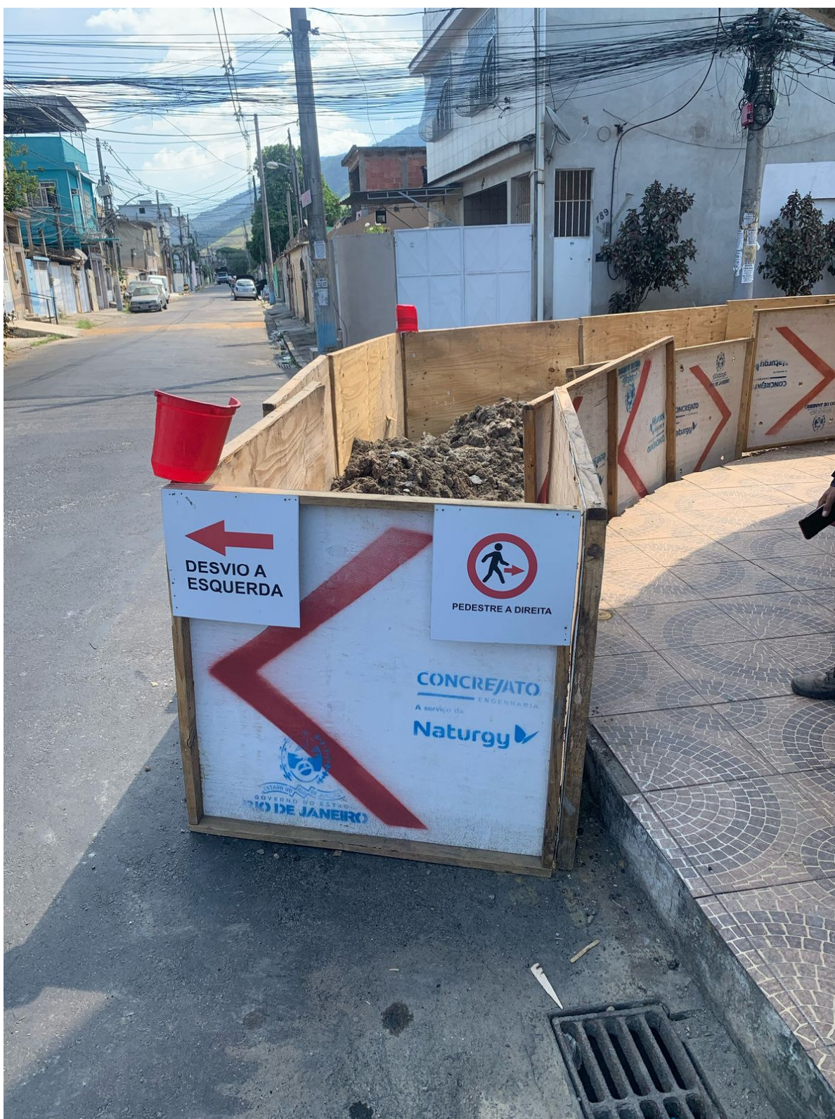
Foto 6: Trecho da obra ainda em construção.
